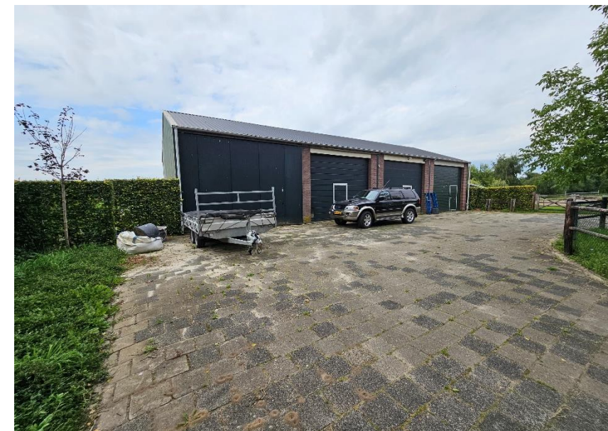
Figuur 12: Garage op erf Plaatse 8
