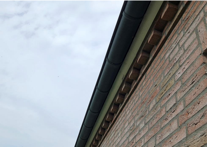
Figuur 27: ruimte tussen dakgoot en dakbeschot woning Heibloem 14
