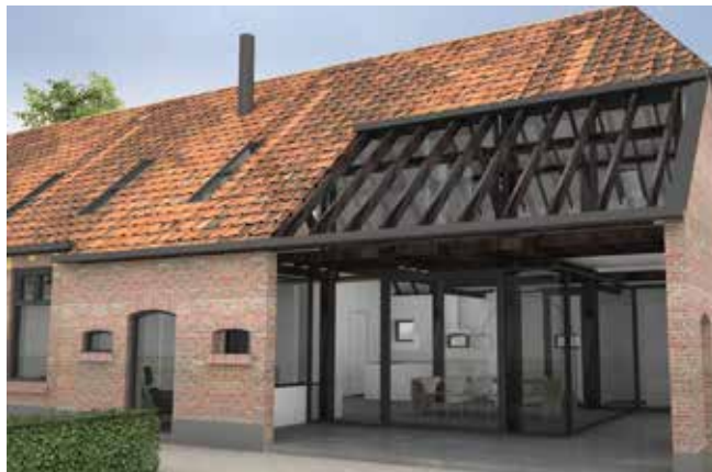
Voorbeeld garage, berging als onderdeel van het volume
