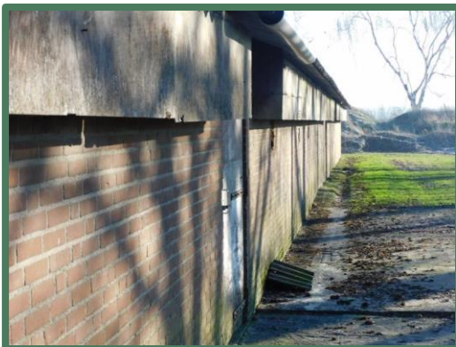
Zuidelijke zijgevel varkensstal
