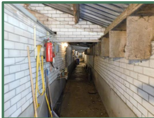
Binnenzijde varkensstal centrale gang
