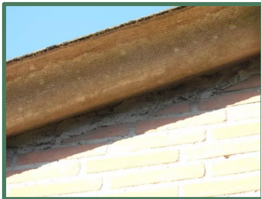
Dak varkensstal dichtgesmeerd met cement
