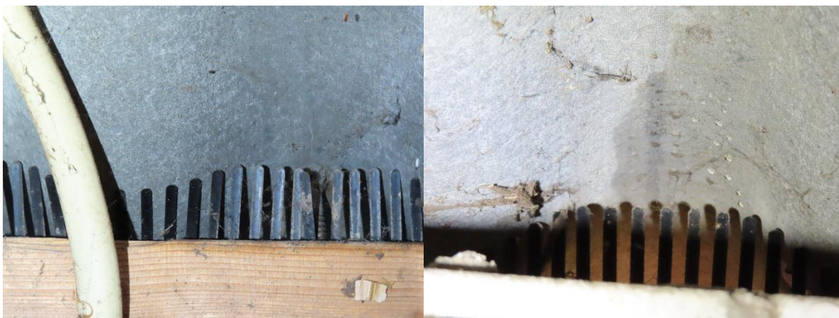
Figuur 7: Geen mogelijkheden voor huismussen in de te slopen bebouwing. Bron: BNL advies.
