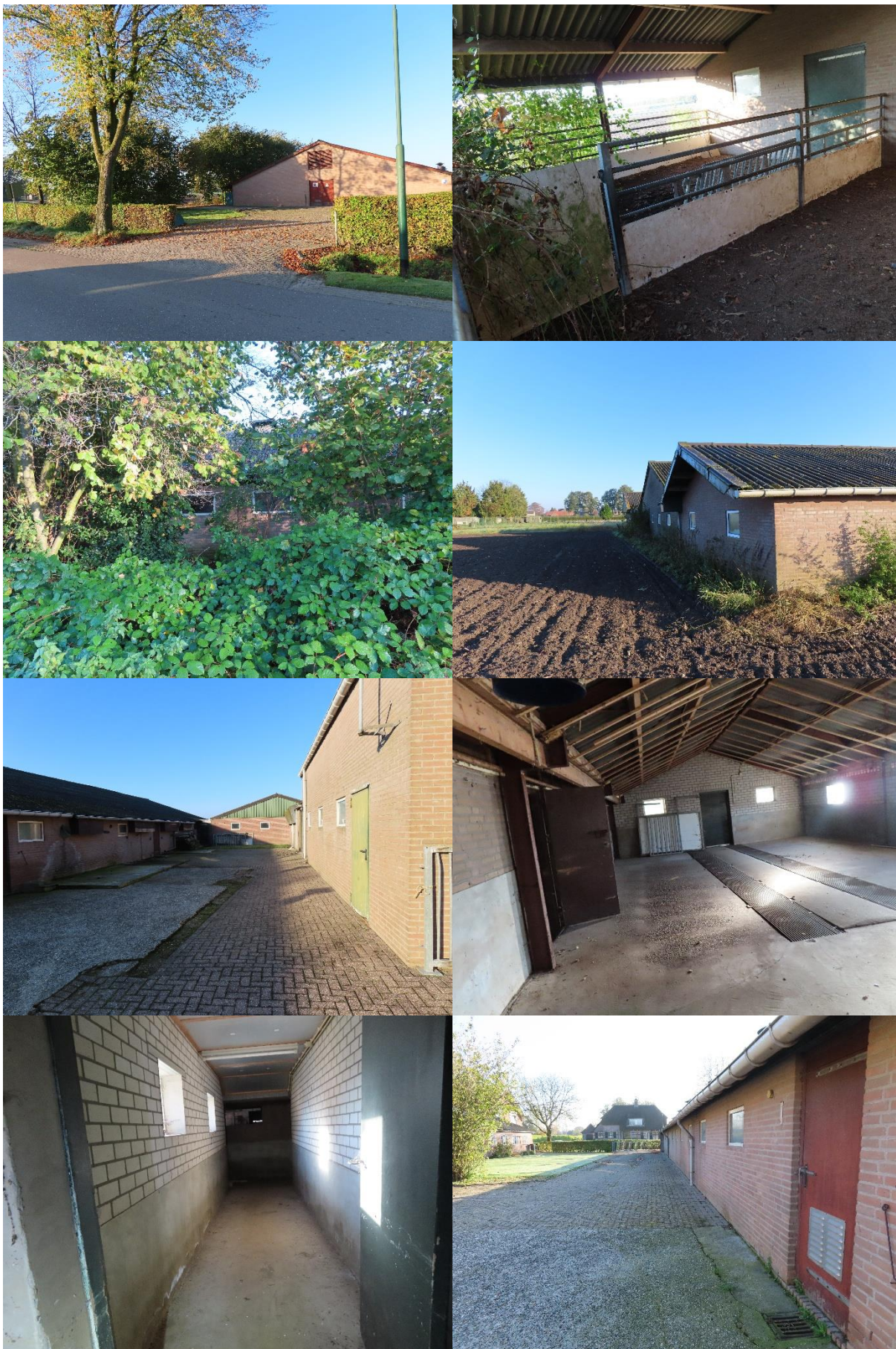
Figuur 3: Bestaande, te slopen bebouwing. Bron: BNL advies
