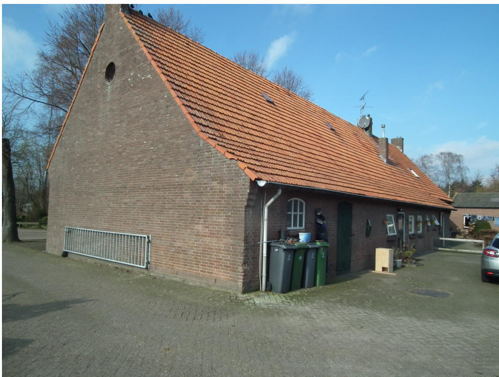
Figuur 2 Het overgrote deel van het perceel is verhard met klinkers. Het dak is afgewerkt met vogelwerende middelen als vogelschroot. Tevens is er een ruit aanwezig in het zolderraam.
