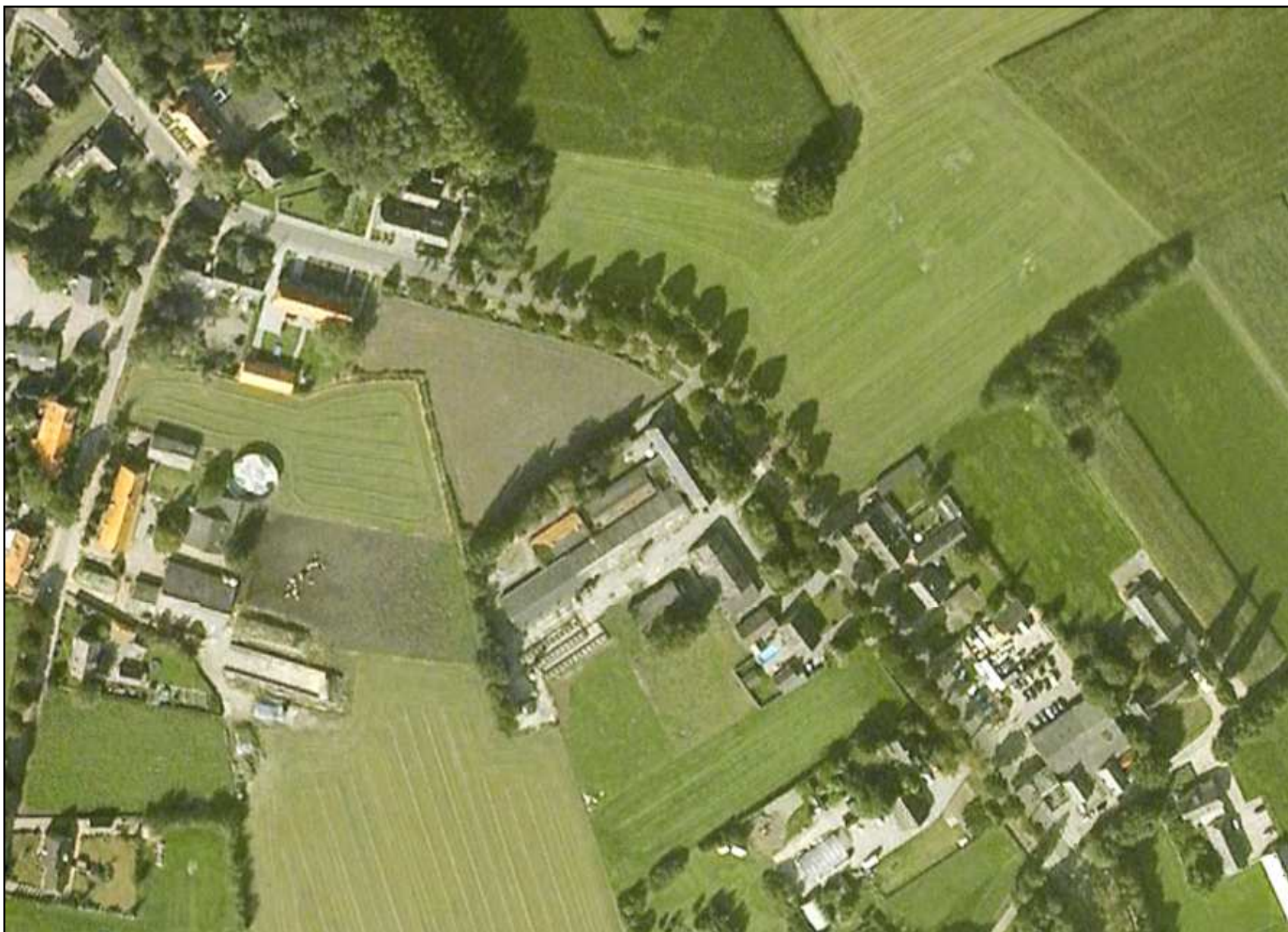
Luchtfoto overzicht huidige situatie plangebied en omgeving
