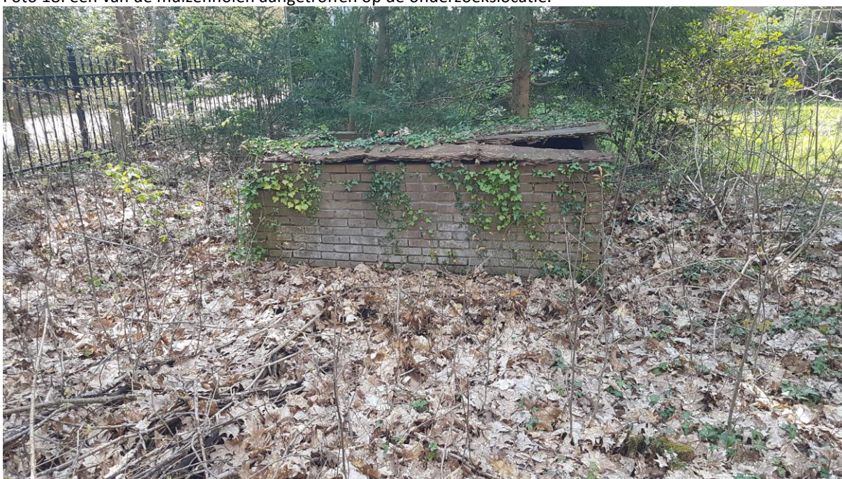
Foto 19: het stenen bouwwerkje op de onderzoekslocatie. de muren hiervan zijn steens gemetseld.
