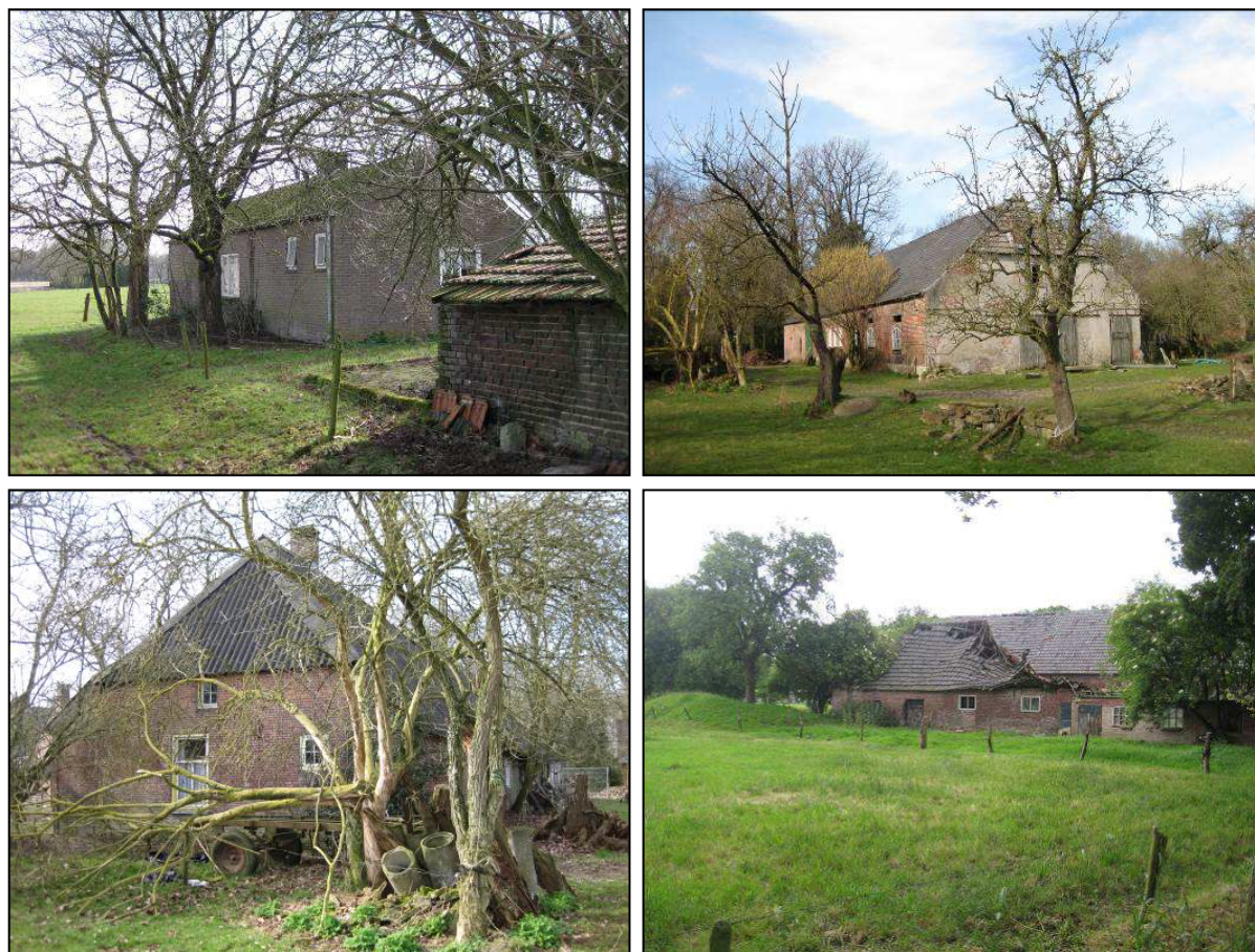
Figuur 5: Foto's bebouwing Postels Huufke 2-4 (deel 1)
