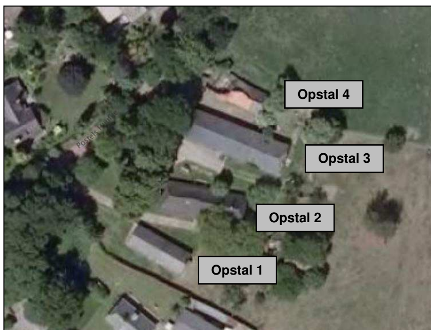
Figuur 38: Overzicht bebouwing Postels Huufke
