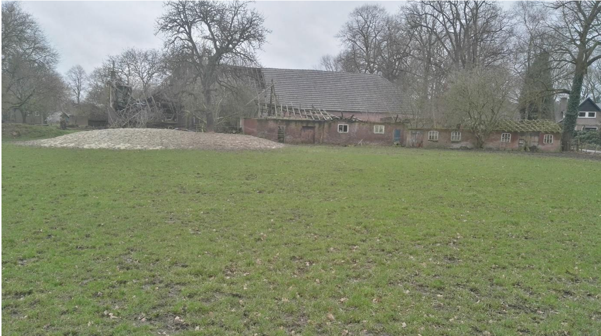
Figuur 16: Noordzijde van de boerderij Postels Huufke 2-4 gezien vanuit het noorden tijdens de uitvoering van het veldwerk.
