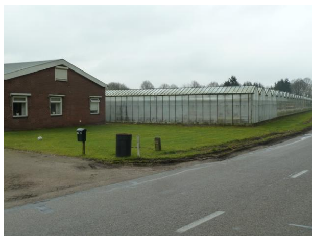
Te slopen bedrijfsgebouw en kassencomplex Mr. de la Courtstraat
