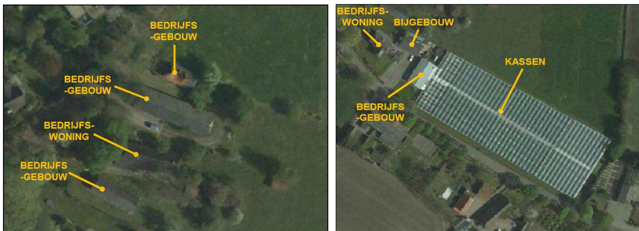
Figuur 2. Overzicht huidige bebouwing plangebied Postels Huufke 2-4 en Mr. de la Courtstraat 15.
