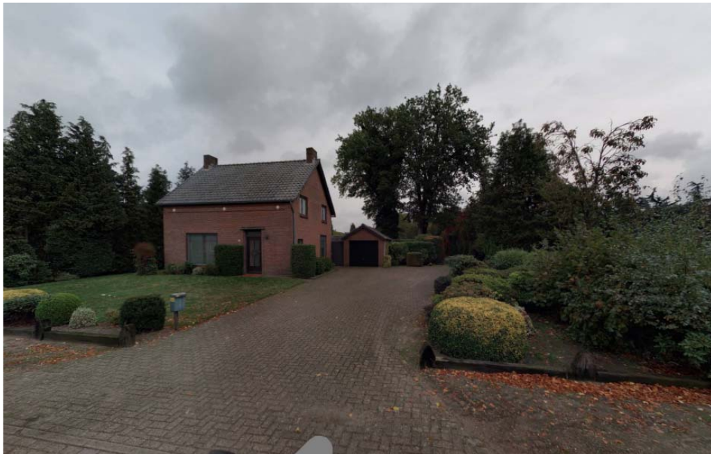
Figuur 4 vooraanzicht van de huidige woning Kuilenhurk 24
