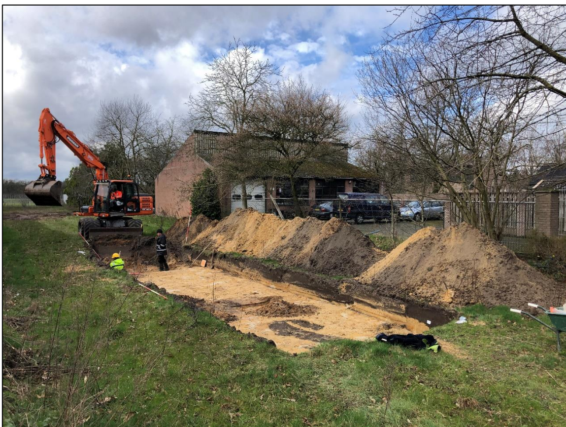
Figuur 2. Werkzaamheden bij werkput 2.
