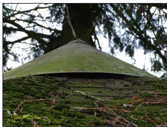
Figuur 17. Ruimte tussen de dakplaten en de dakkoepel van de tuinhuisje.
