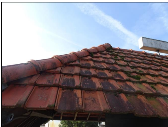
Figuur 10. Schuur met overkapping noordelijk op de onderzoekslocatie heeft geen geschikte ruimtes onder de dakpannen.
