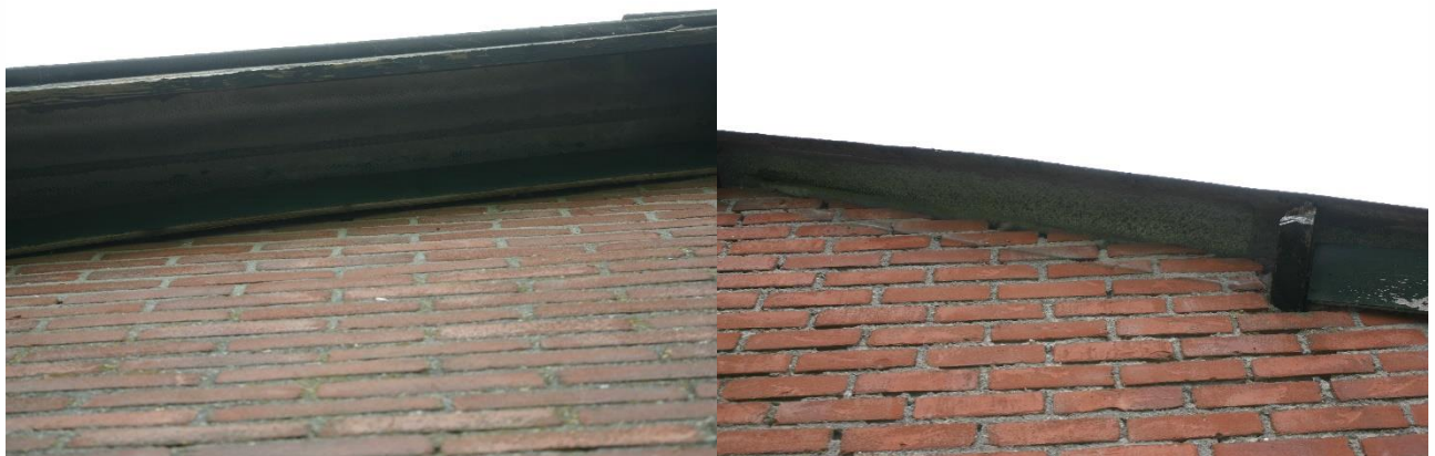
Figuur 4.4.2. De kopgevels van de varkensstallen bevatten meerdere spleten en openingen waardoor vleermuizen de spouw kunnen bereiken.
