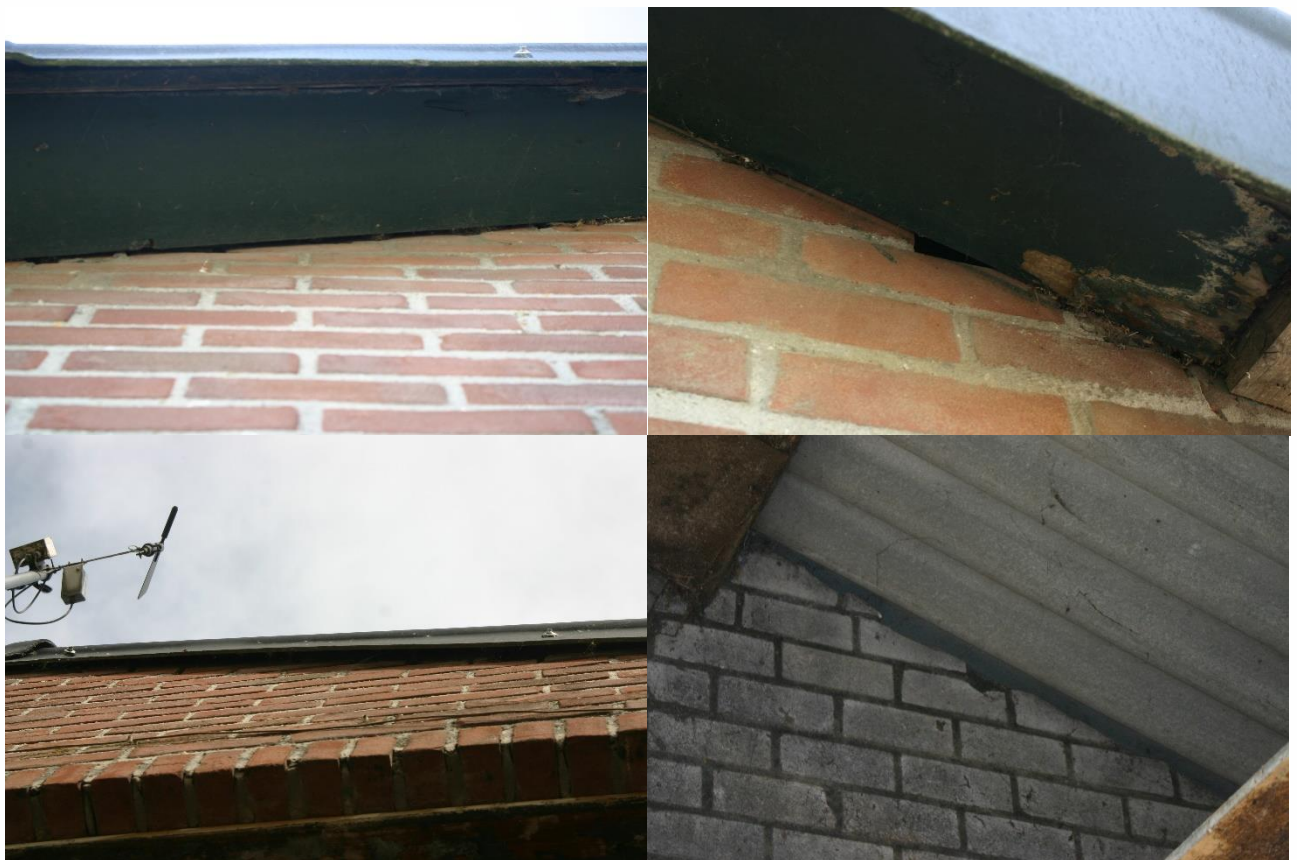
Figuur 4.4.5. Tussen het dak overstek en de noordelijke kopgevels bevinden zich spleten (bovenste foto's) en de zuidelijke kopgevels bevatten een windveer die kiert met de gevel (foto linksonder). De spouw is ook van binnenuit bereikbaar (rechtsonder). Vleermuizen hebben op deze plekken dus toegang tot de spouw.
