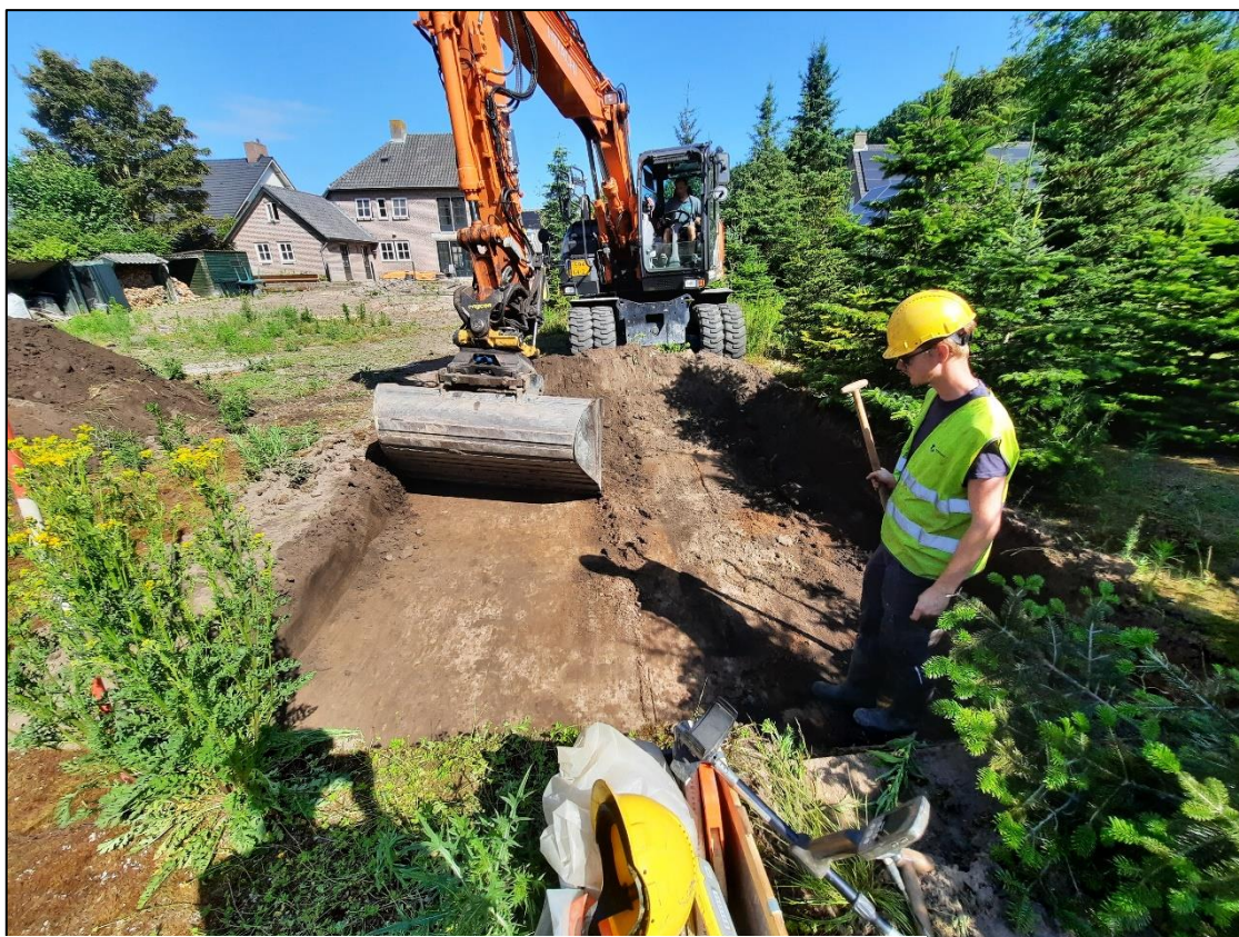
Figuur 6: De start van de aanleg van werkput 1.
