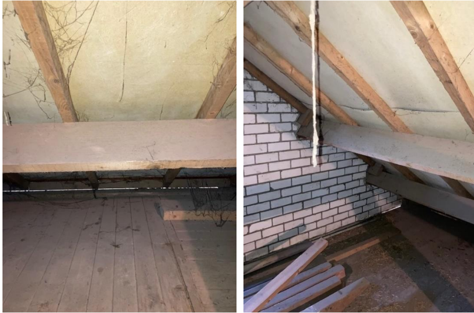
Afbeelding 15 kap garage strak afgewerkt zonder openingen of kieren
