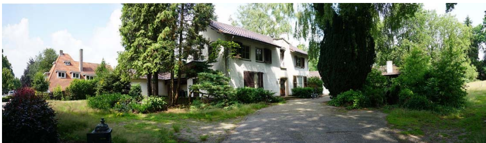
De leegstaande villa in het plangebied
