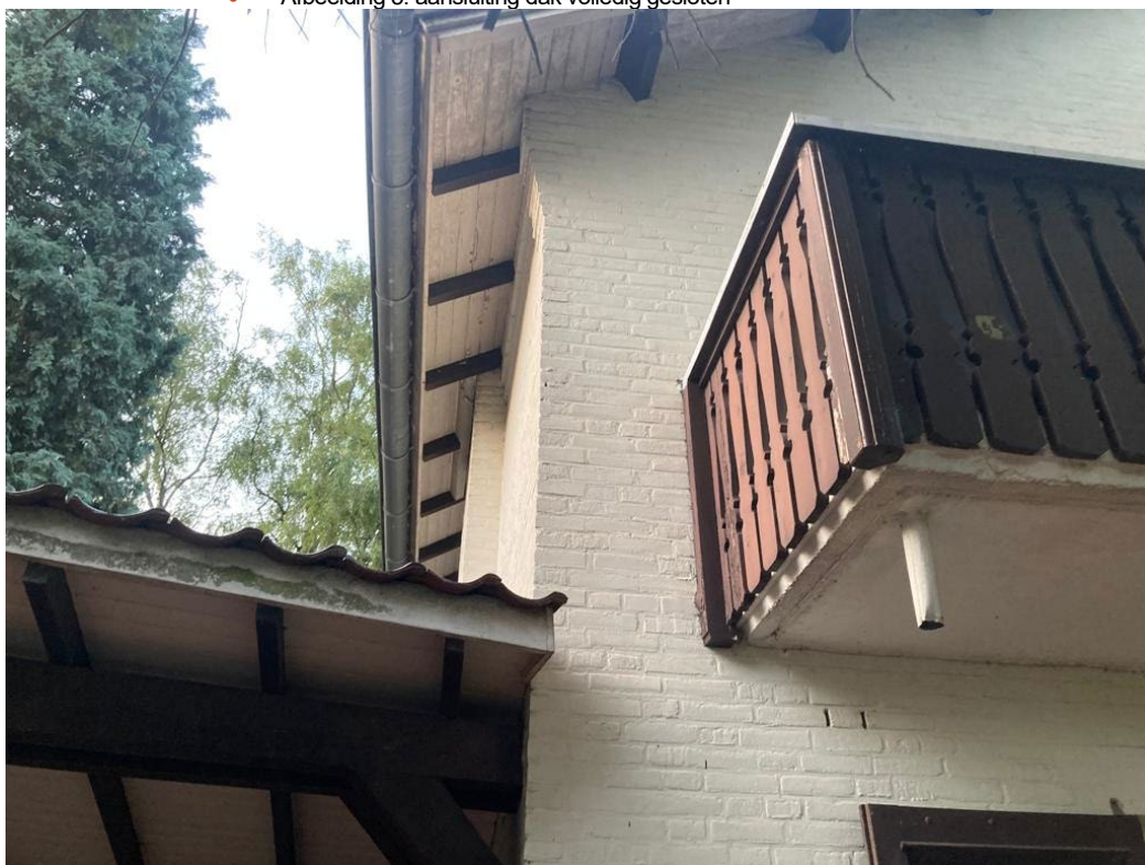
• Afbeelding 5: aansluiting dak volledig gesloten
