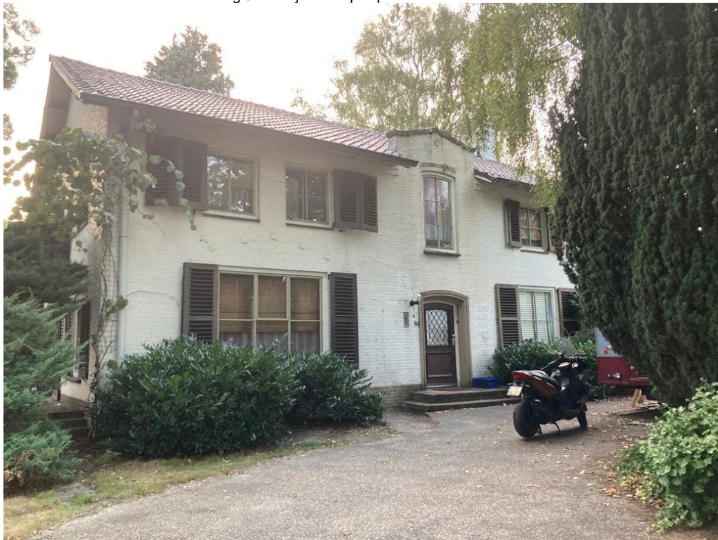
• Afbeelding 3: voorzijde te slopen pand
