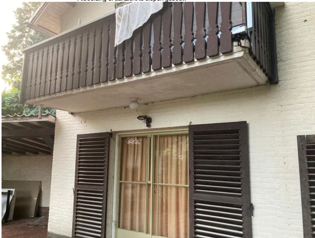
• Afbeelding 6: aanzicht te slopen gebouw
