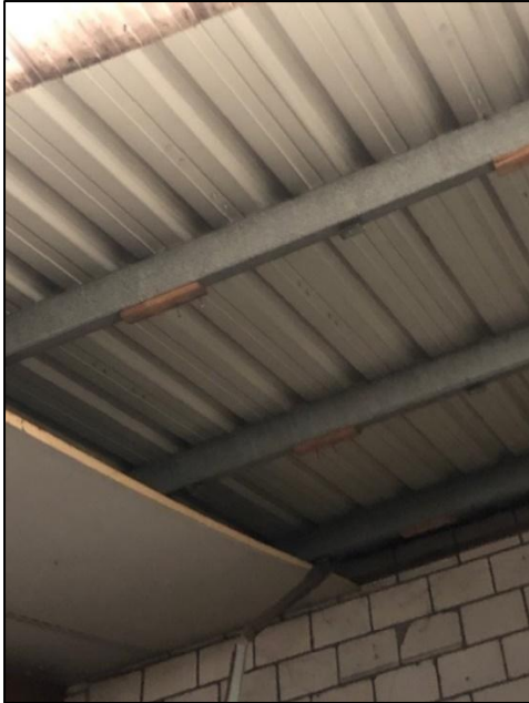
Afbeelding 29 Metalen dakopbouw bedrijfsgebouw
