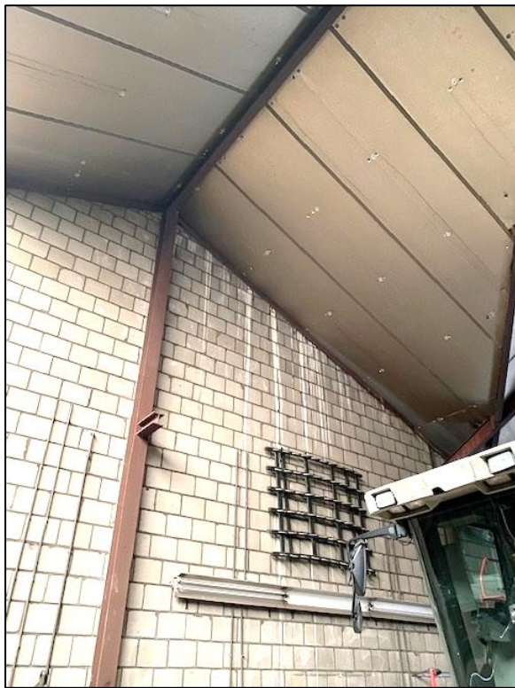
Afbeelding 27 Detailfoto's nok en binnengevel, spouwmuur zonder holtes, isolatie zonder holtes
