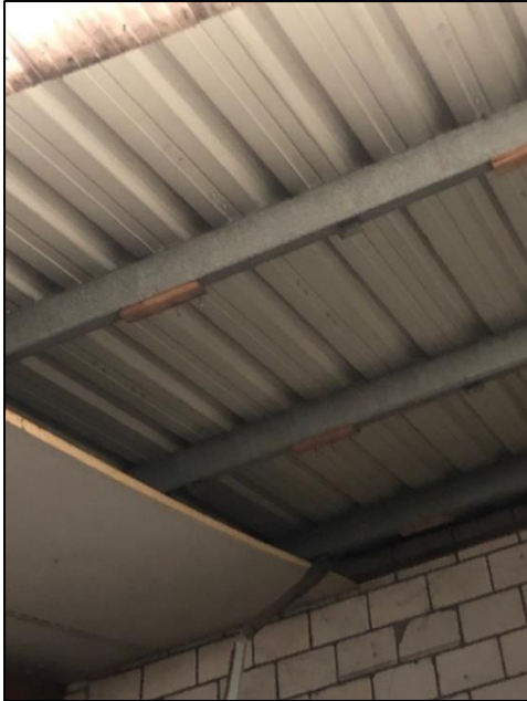
Afbeelding 29 Metalen dakopbouw bedrijfsgebouw
