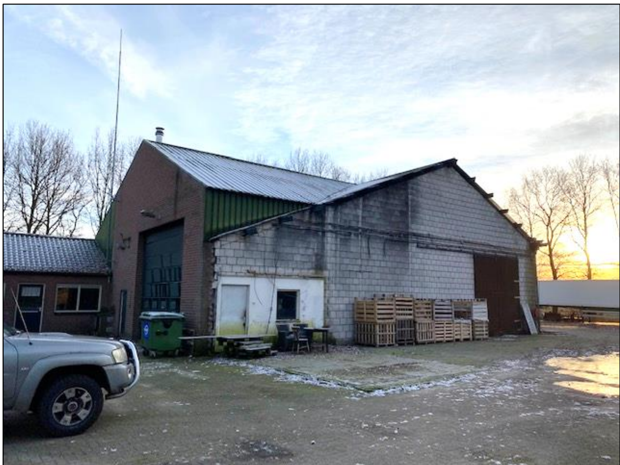
Afbeelding 24 Overzichtsfoto resterende loods na brand
