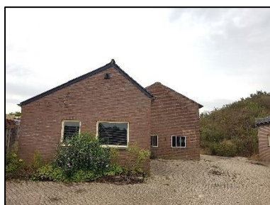
Figuur 3. Schuur annex garage in het zuidwestelijk deel
