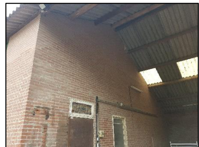
Figuur 14. Onder de golfplaten is ruimte die toegang verleent tot de spouwmuur
