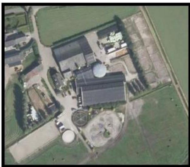
Afbeelding 5: Luchtfoto huidige situatie
