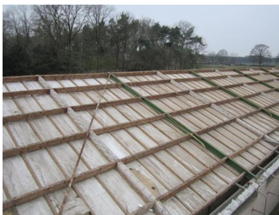
Foto 2 : Hier zijn de golfplaten verwijderd.
