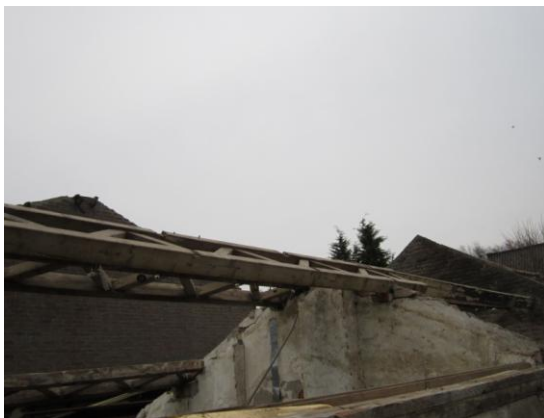
Foto 3 : Hier zijn de golfplaten verwijderd.
