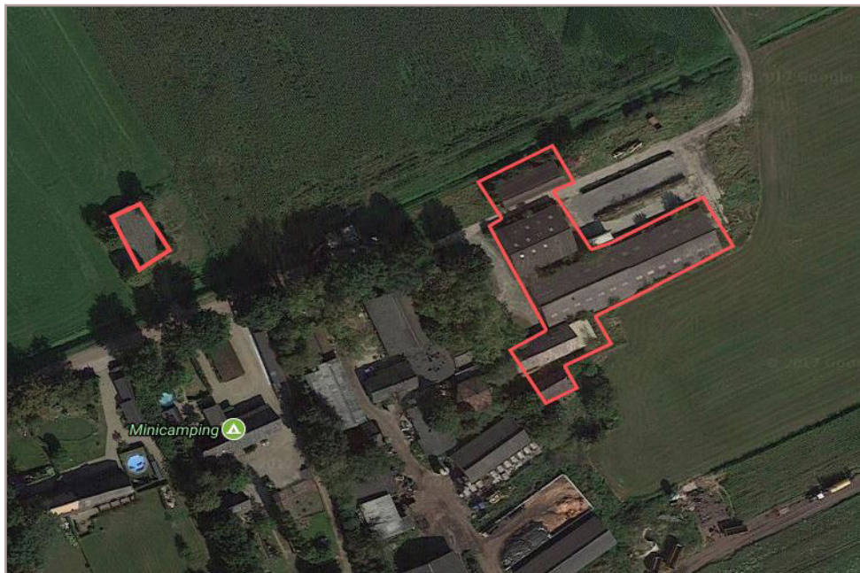
Figuur 1 Globale situering van de te slopen opstaallen / het plangebied (in rood). Bron luchtfoto: Google.
