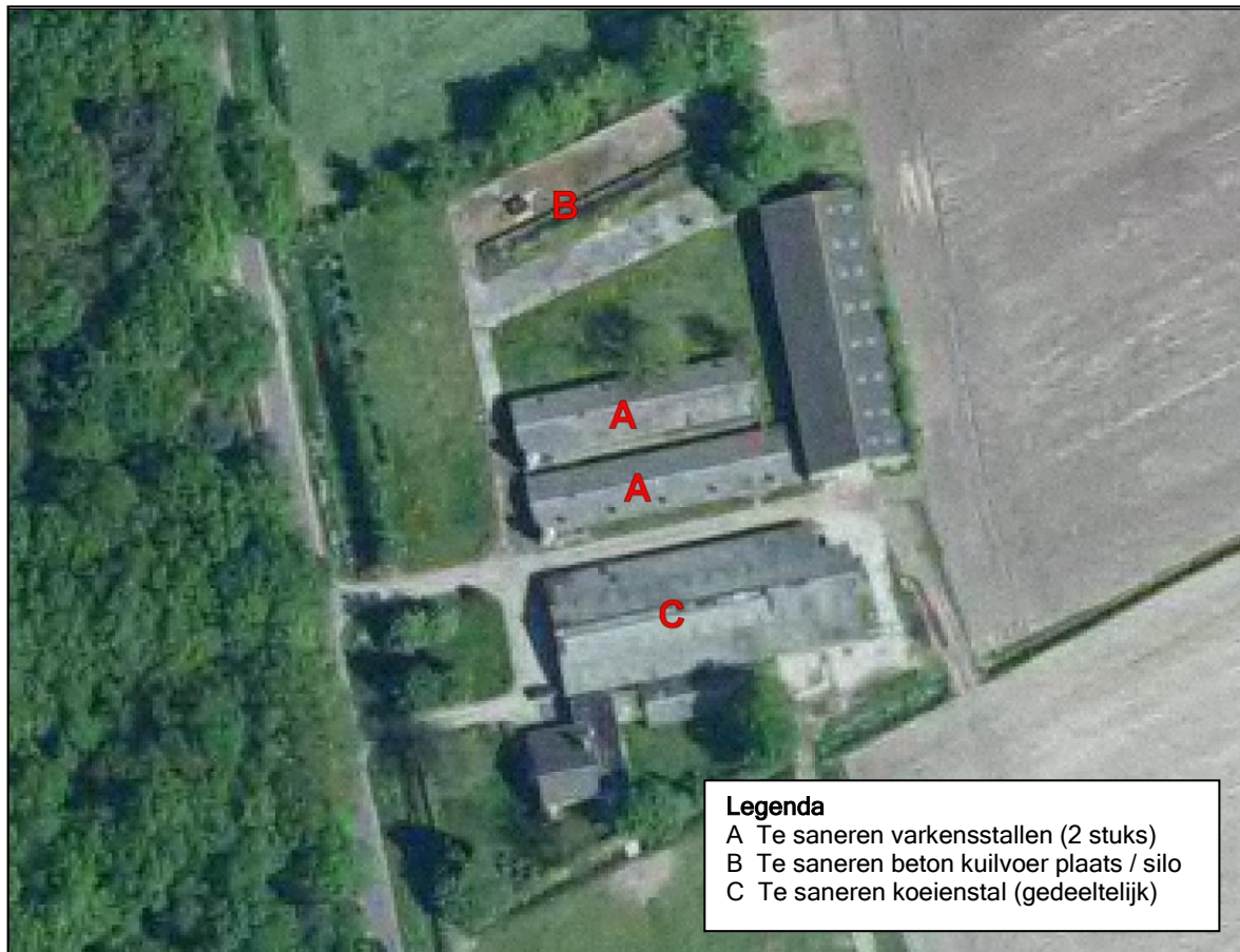
Figuur 17 Sanering bestaande gebouwen
