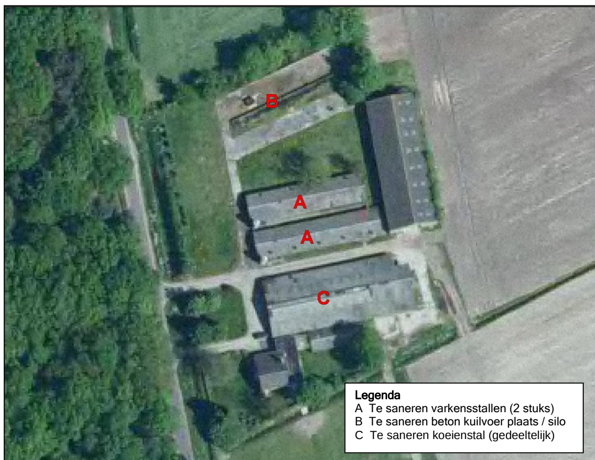
Figuur 16 Sanering bestaande gebouwen
