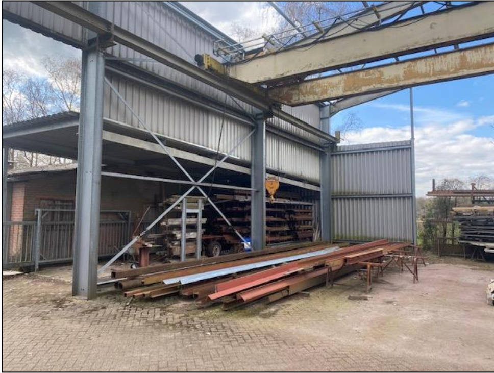
Afbeelding 6 Opslagplaats met kraanbaan
