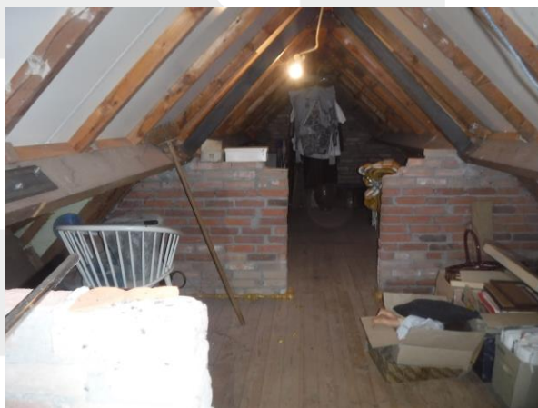
Zolderruimte van de woning. Goed afgesloten kapconstructie met isolatiepanelen.
