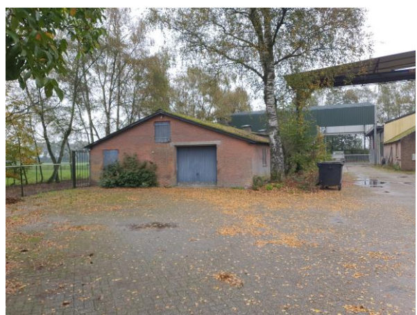
Loods met gemetselde gevels en golfplaten dakbedekking. Op de achtergrond de kraanbanen en een gedeelte van de andere loods.
