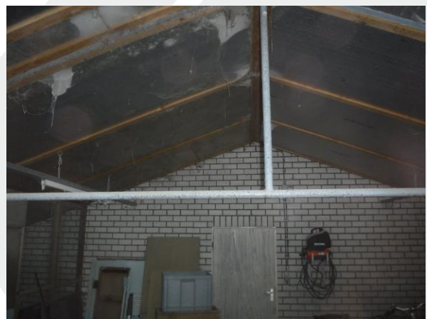
Beeld binnenkant loods met gemetselde gevels. Betonnen vloeren. Volledig gesloten dakisolatie van dupanel.
