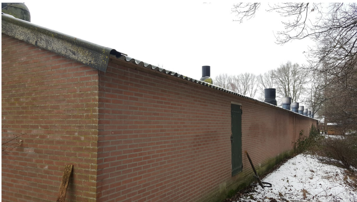
Oostelijke zijde van de te slopen stal aan de Ingenieur van Meelweg 3. Foto: B. Verhoeven | Ecoresult. B.V.
