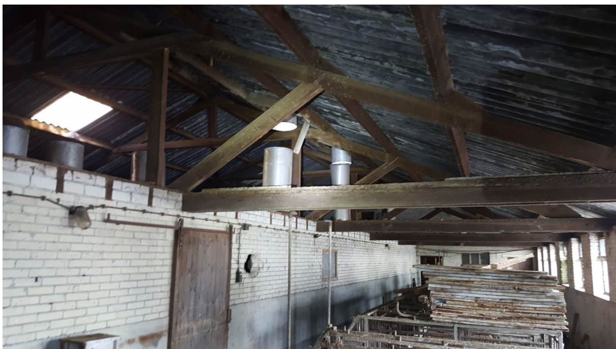
Binnenzijde stal aan de Ingenieur van Meelweg 2. Foto: B. Verhoeven | Ecoresult. B.V.
