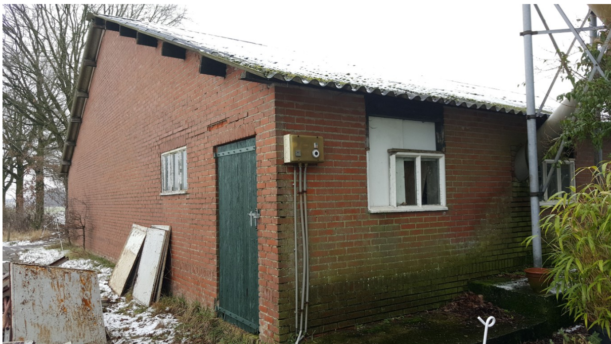
Kopse gevel aan de westzijde van de te slopen stal aan de Ingenieur van Meelweg 2. Foto: B. Verhoeven | Ecoresult. B.V.
