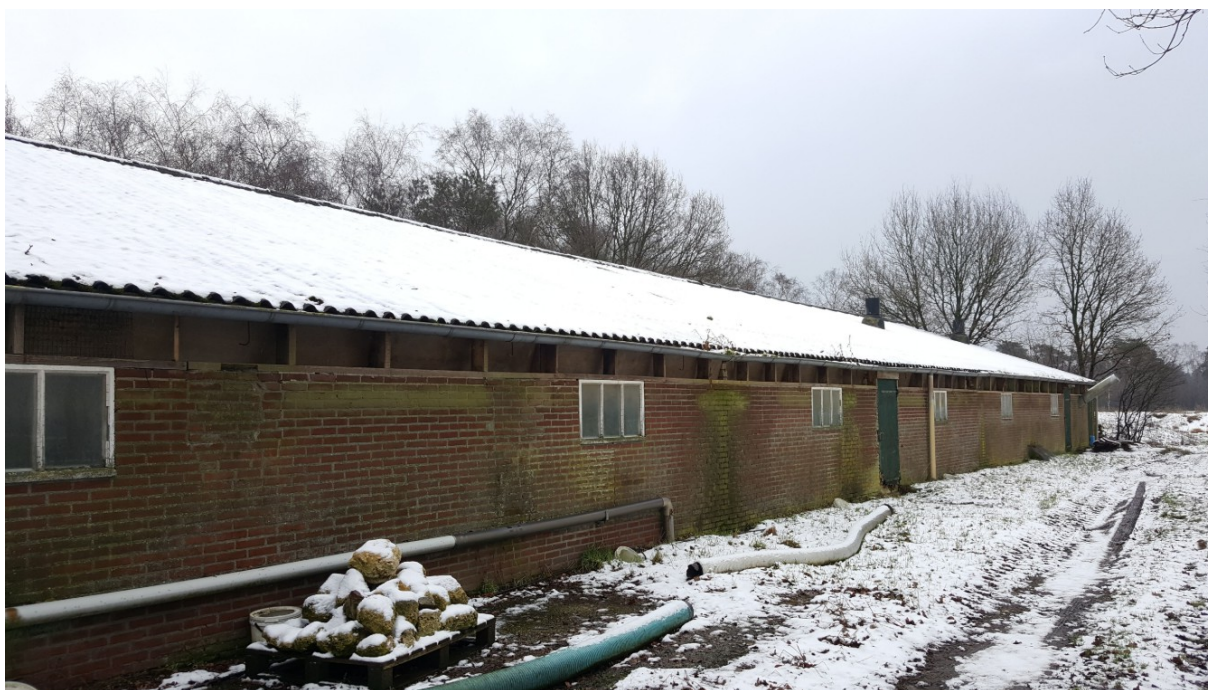
Westelijke zijde van de te slopen stal aan de Ingenieur van Meelweg 3. Foto: B. Verhoeven | Ecoresult. B.V.
