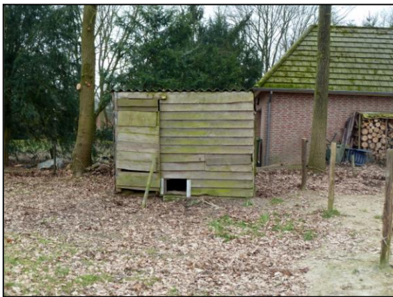
Te slopen bebouwing
