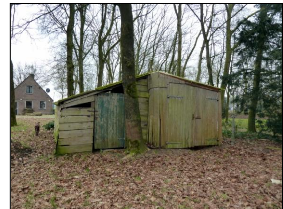
Te slopen bebouwing
