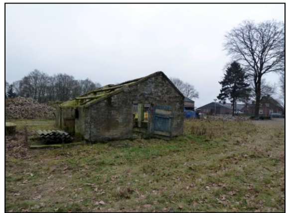
Te slopen bebouwing
