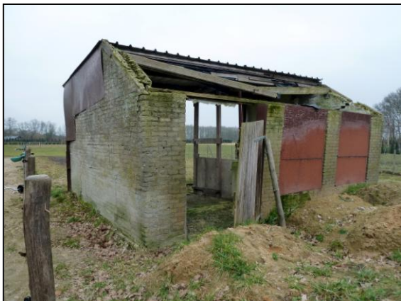
Te slopen bebouwing
