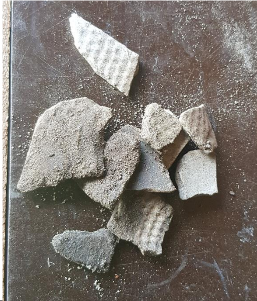
aangetroffen asbestverdachte fragmenten op maaiveld tijdens maaiveldinspectie
