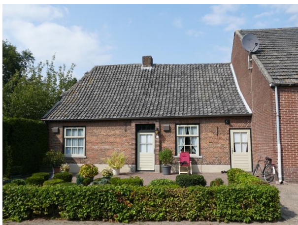
Afb. 4. Voorgevel (zuidzijde) van woongedeelte.
