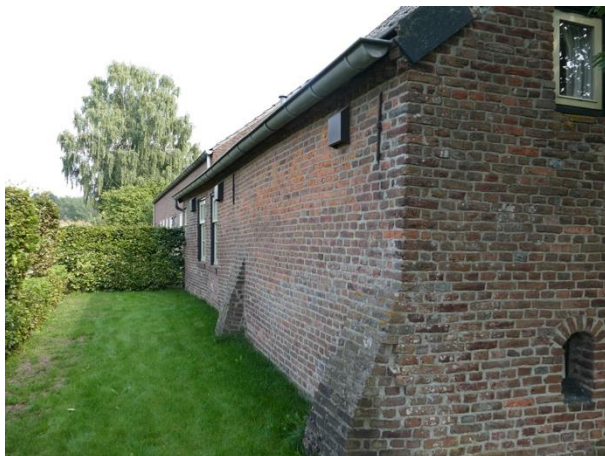
Afb. 8. Kopgevel en achtergevel met steunberen.
