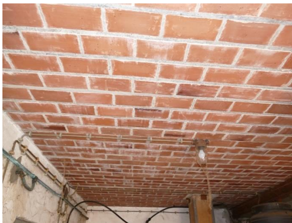
Afb. 28. Plafond van rode holle baksteen in voorstal.
