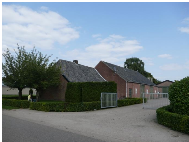
Afb. 22. Zuidgevel van schuurgedeelte.
