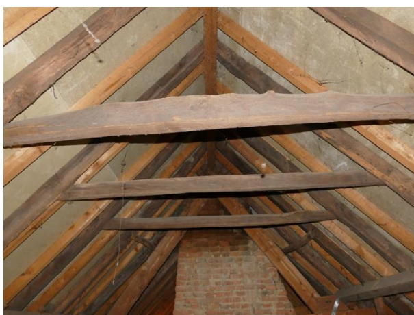
Afb. 17. Oude sporenkap in voorste deel van de zolder.
