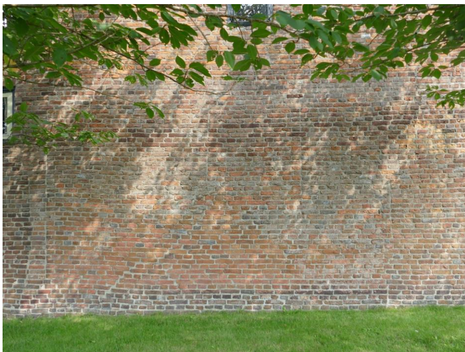
Afb. 10. Kopgevel met diverse bouwsporen.
