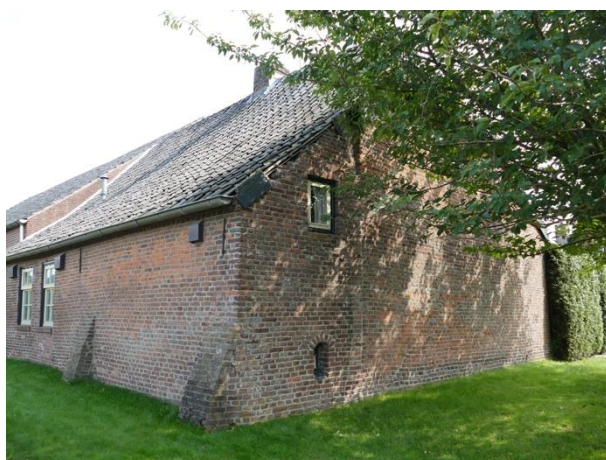
Afb. 6. Kopgevel (westzijde) en achtergevel (noordzijde).
