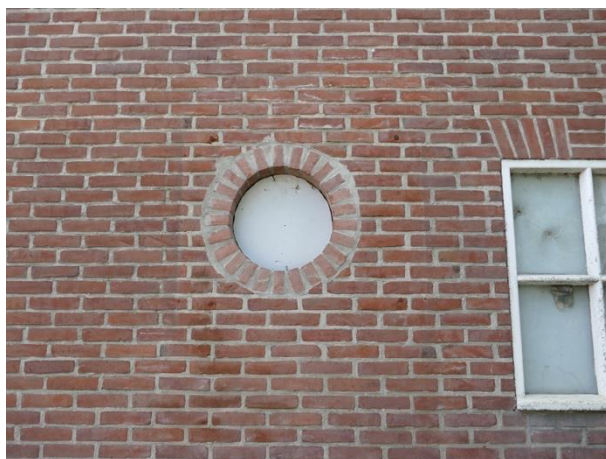
Afb. 24. Ronde ventilatieopening met rollaag aangebracht in bestaande muur.
