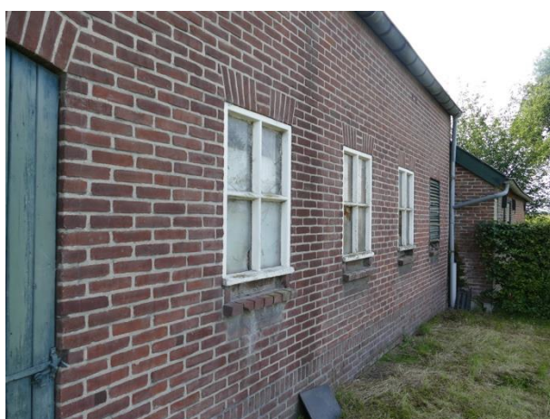
Afb. 26. Rechter deel van de stal met aansluiting van het woongedeelte.
