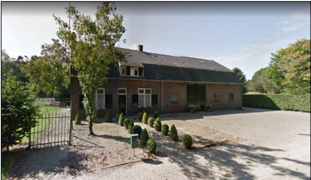
Afbeelding 3: Zichtfoto woonboerderij Lantie 3 te Vessem
