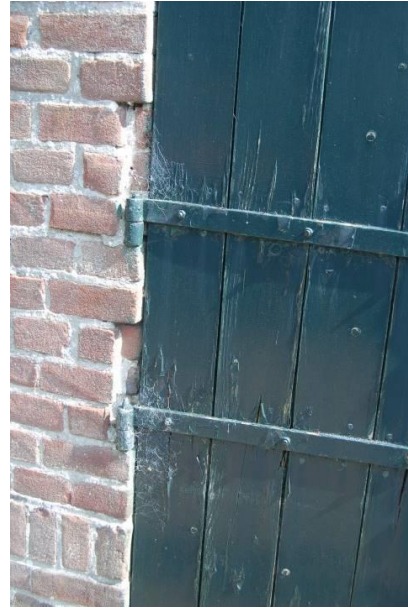
Afb. 24. Varkensdeurtje met ijzeren gehengen
