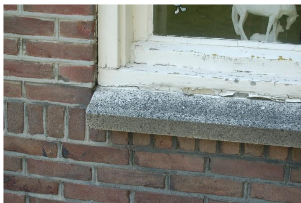
Afb. 18. Detailopname van één van de lekdorpels
