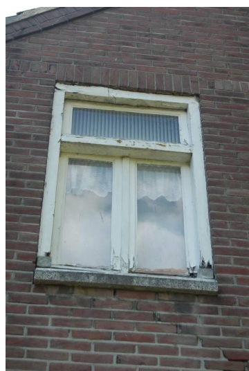
Afb. 17. Venster op de bovenverdieping
