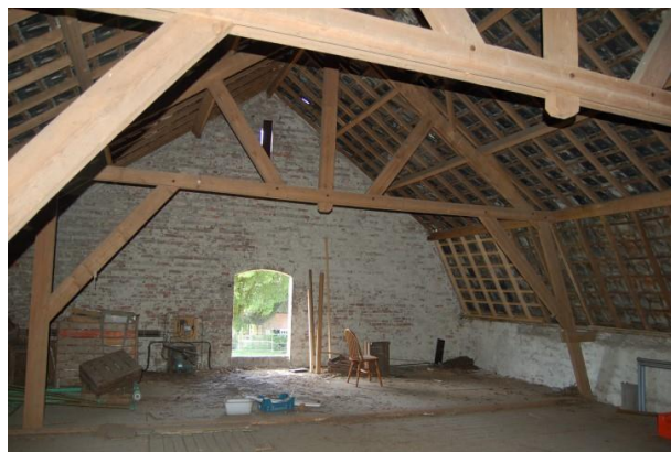
Afb. 30. Zolderverdieping met houten kapconstructie
