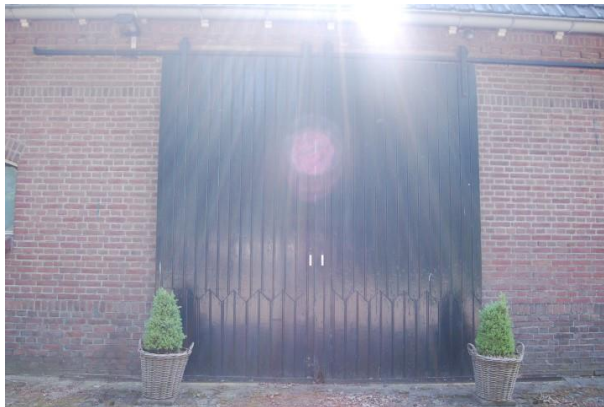
Afb. 11. Schuurdeuren aan ijzeren rail.
