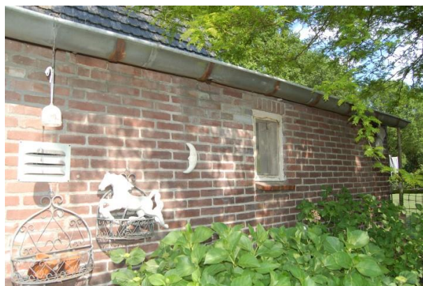
Afb. 28. Inboetwerk in de achtergevel
