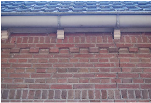
Afb. 10 Bloktand langs de gevel en houten gootklossen
