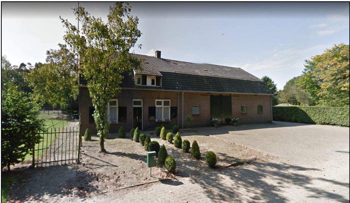
Afbeelding 3: Zichtfoto woonboerderij Lantie 3 te Vessem
