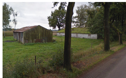
Afb: Huidige gebouwen aan Hazenstraat 23 die gesaneerd zullen worden
