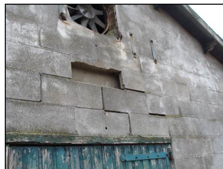
Foto 15. Toegang tot spouwmuur Hazenstraat 23
