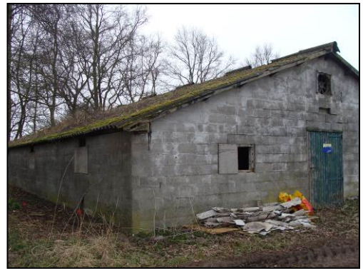
Foto 6. Westelijk gelegen opstal Hazenstraat 9
