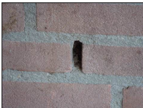
Foto 14. Toegang tot spouwmuur van stal Hazenstraat 9
