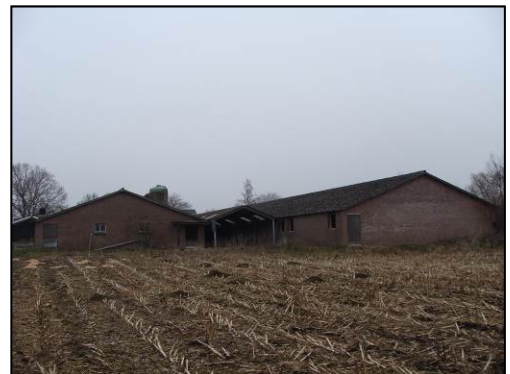
Foto 2. Maisakker en achterzijde bedrijfsgebouwen Hazenstraat 9
