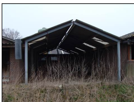
Foto 12. Open schuur Hazenstraat 9
