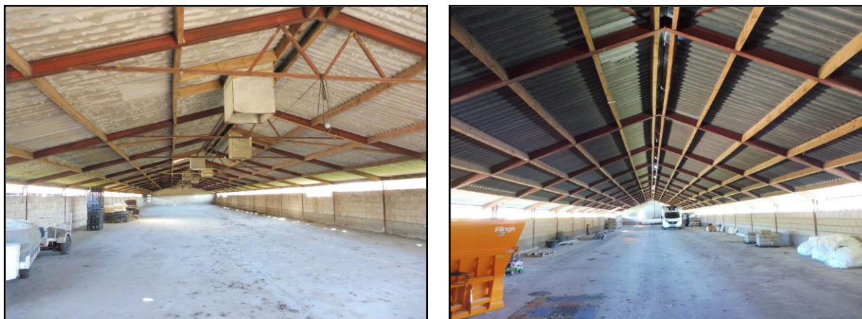
Figuur 5-6. Indruk van de binnenzijde te slopen stallen.
