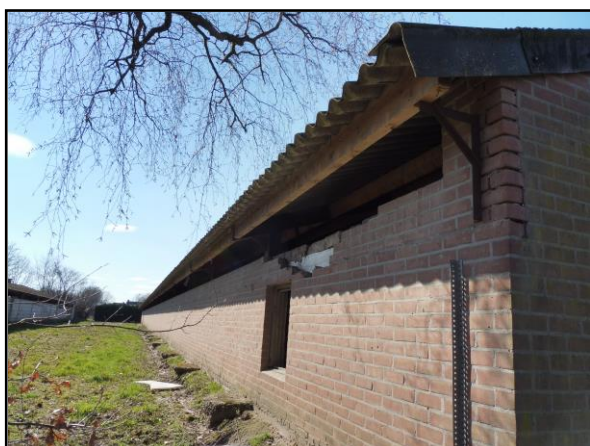
Indruk van de te slopen voormalige kippenstallen.
