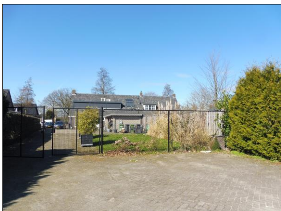
Zicht op de langgevelboerderij vanuit het achtererf.
