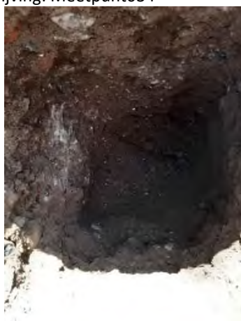
Fotonummer: 9 Omschrijving: Meetpunt 034a
