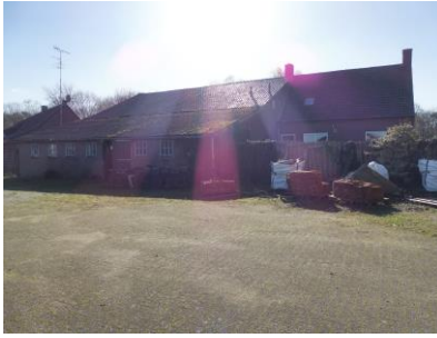
Zicht op de achterzijde te splitsen langgevelboerderij.
