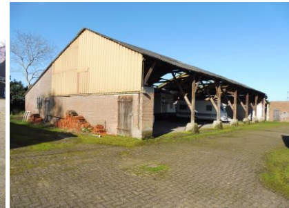
Te slopen veldschuur met vleermuiskast aan de binnenzijde.
