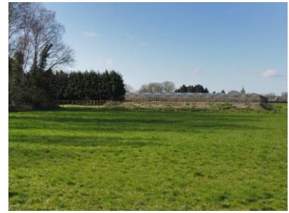
Zicht op te slopen kassencomplex Bussereind nr. 3 vanuit oostelijke richting.
