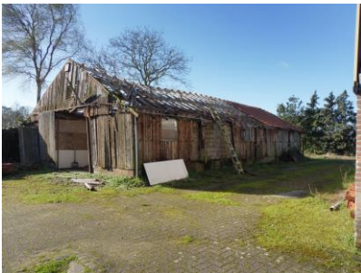
Te slopen bebouwing met vleermuiskast op kopgevel.
