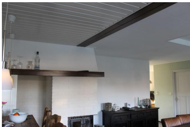
Plaats verwijderde brandmuur
