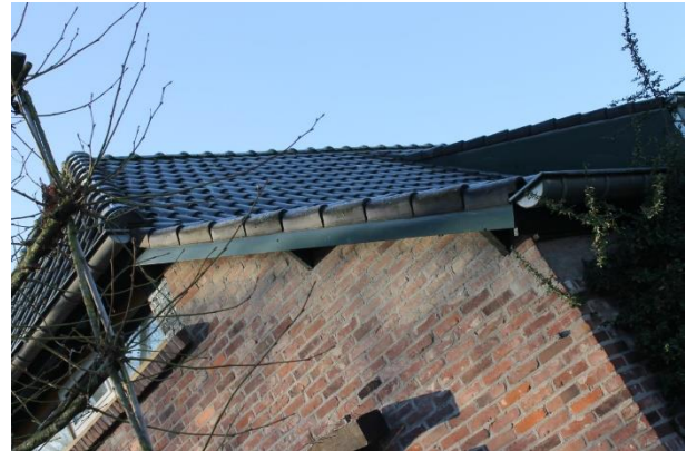
De ophoging van de gevel
