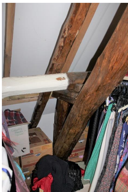
Rondhouten delen uit de bouwperiode en machinaal gezaagde delen uit de jaren '90
