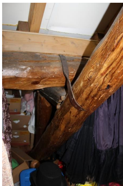
Rondhouten delen uit de bouwperiode en machinaal gezaagde delen uit de jaren '90
