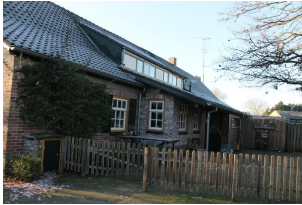
De achtergevel van het bedrijfsgedeelte
