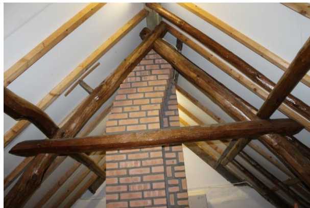
Spantconstructie uit de bouwperiode van de boerderij en nieuw machinaal gezaagde sporen
