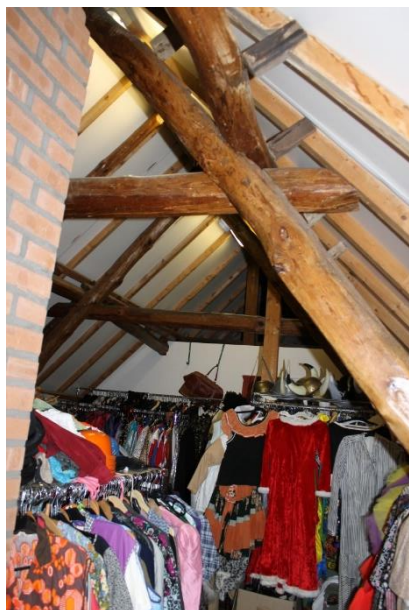
Spantconstructie uit de bouwperiode van de boerderij en nieuw machinaal gezaagde sporen
