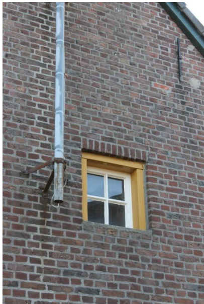
Oorspronkelijk venster in de topgevel
