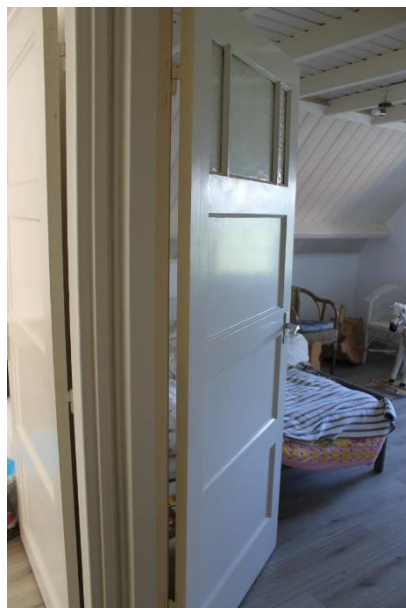
Deuren en schrootjesplafond uit de bouwperiode
