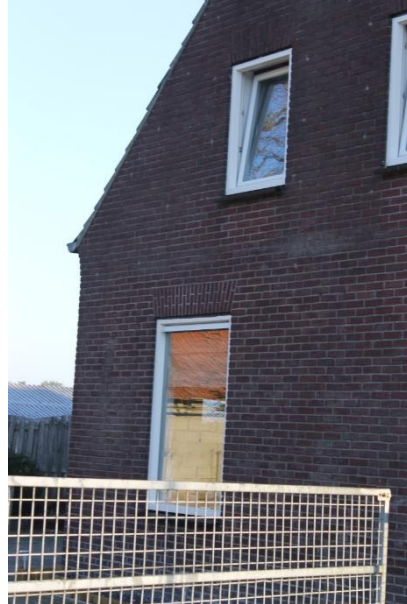
Vernieuwd venster in oorspronkelijke opening
