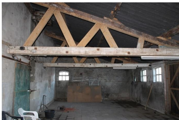
Spantconstructie in de aanbouw
