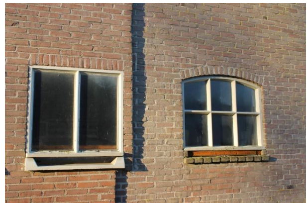
Links de gevel en beton venster uit eind jaren '60 en rechts de gevel van de aanbouw met betonvenster uit de jaren '50
