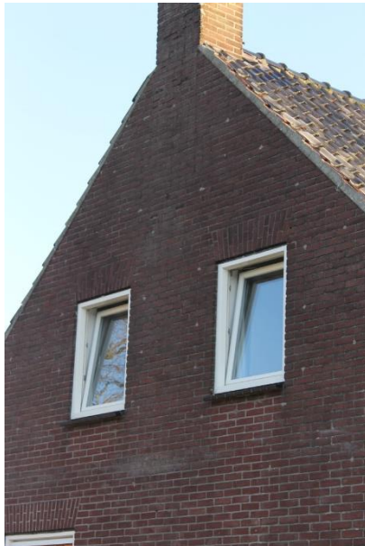
Vernieuwde vensters in oorspronkelijke openingen
