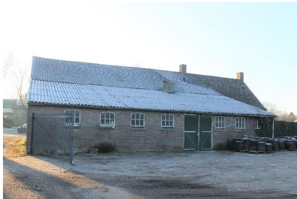
Achtergevel uitbreiding bedrijfsgedeelte uit jaren '50 van de 20 ste eeuw
