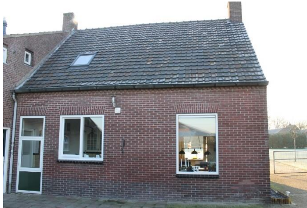
Achtergevel met vernieuwde vensters en deur
