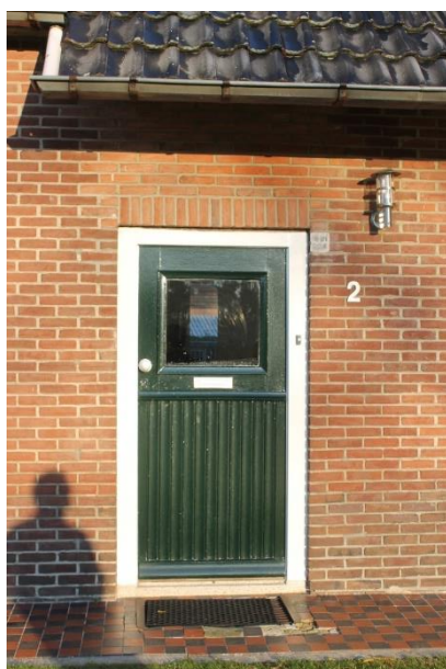
De voordeur vermoedelijk uit de bouwperiode van de schuur
