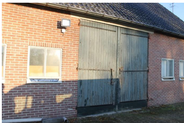
Betonnen stalvensters en deuren uit de bouwperiode van de schuur
