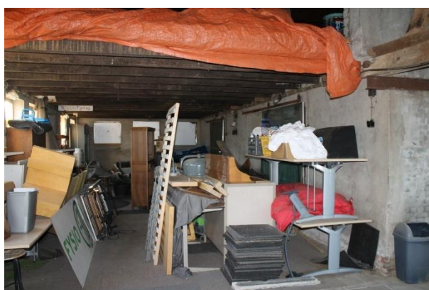
De ruimte rechts in het bedrijfsgedeelte (foto is van achteren naar voren genomen) met rechts de scheidingsmuur tussen de twee ruimten
