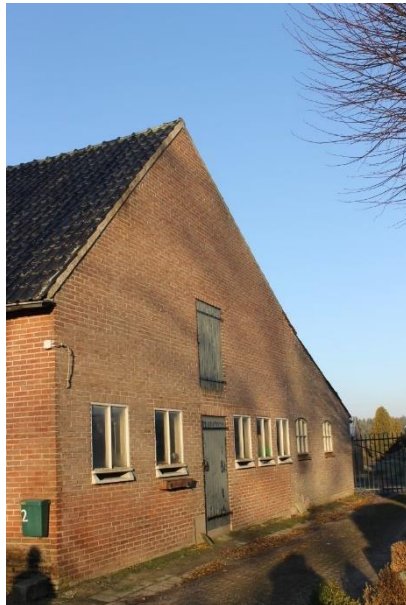
De rechterzijgevel van het bedrijfsgedeelte met de aanbouw
