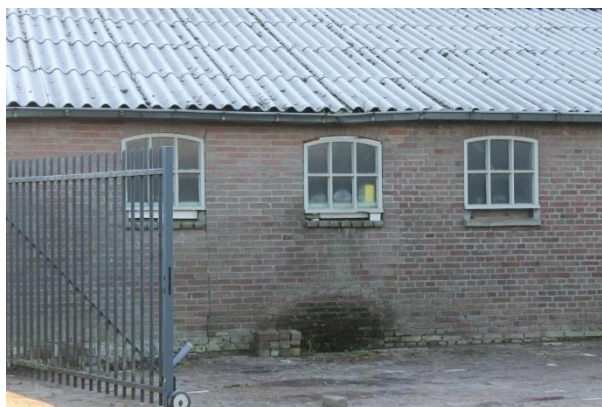
Beton vensters uit de jaren '50 van de 20 ste eeuw
