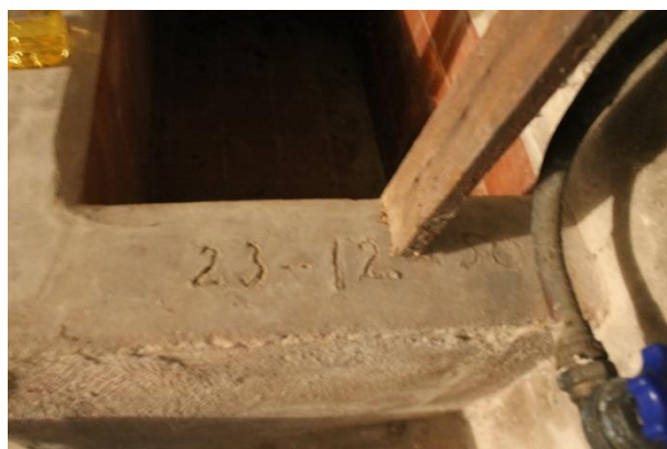
Datum bouw woning gekrast in pekelbak in de kelder
