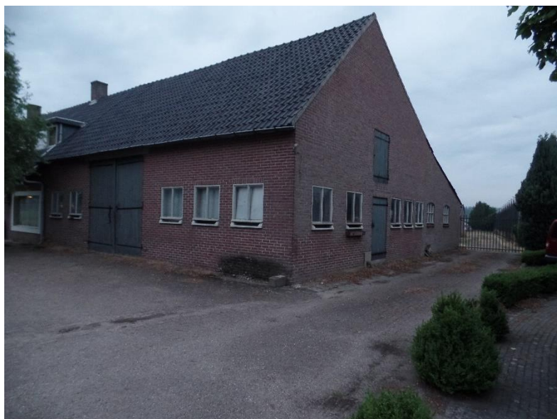
Fig.5. Stalgedeelte van de woning
