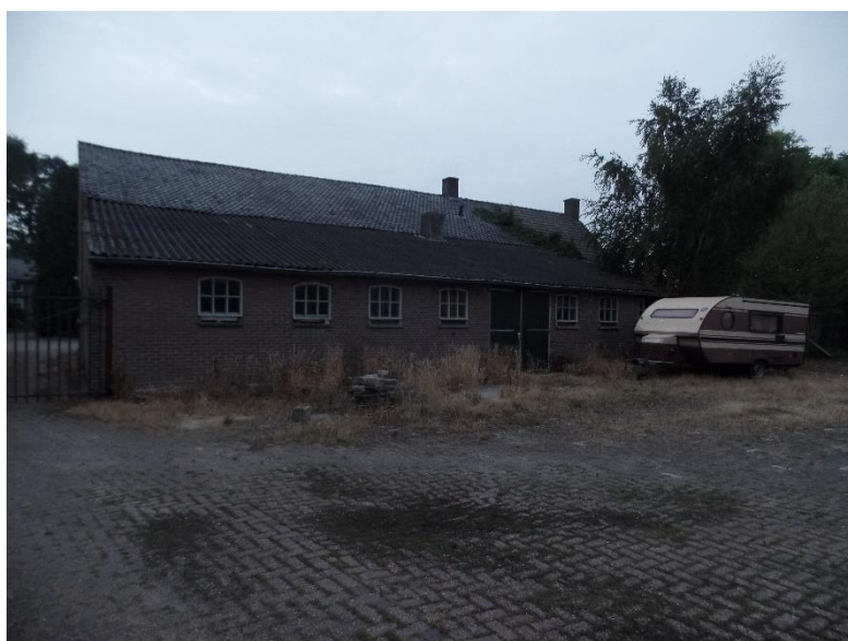
Fig.6. Zicht op achterkant van woning
