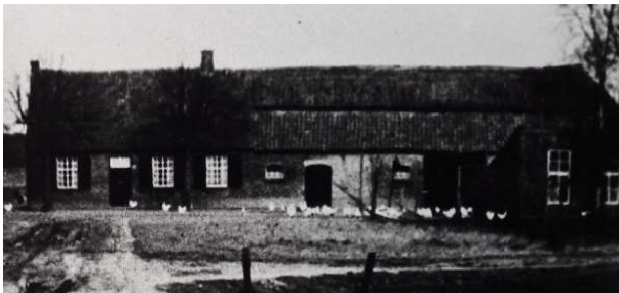
Afb. 9; vóór 1930, de oudste afbeelding, uitsnede van afb. 27. Het bovenste deel van het dak is nog met riet gedekt.
