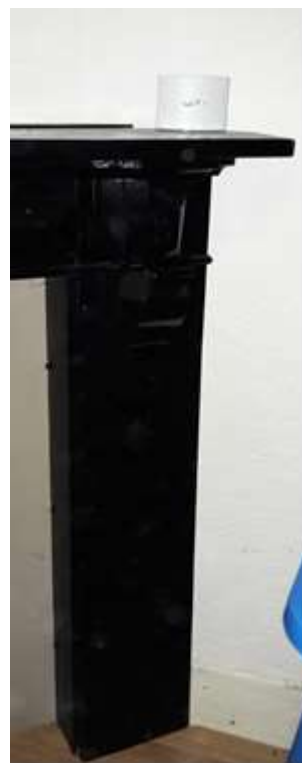
Afb. 24b; hoekschoorsteen ruimte VI, stramien 3.
