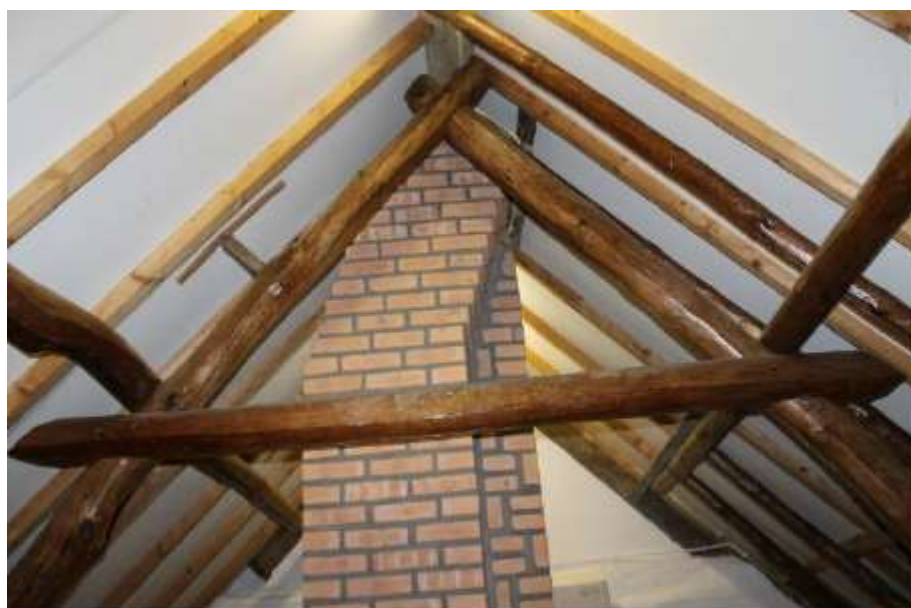
Afb. 23; oorspronkelijke kapconstructie stramien 4 westwaarts.
