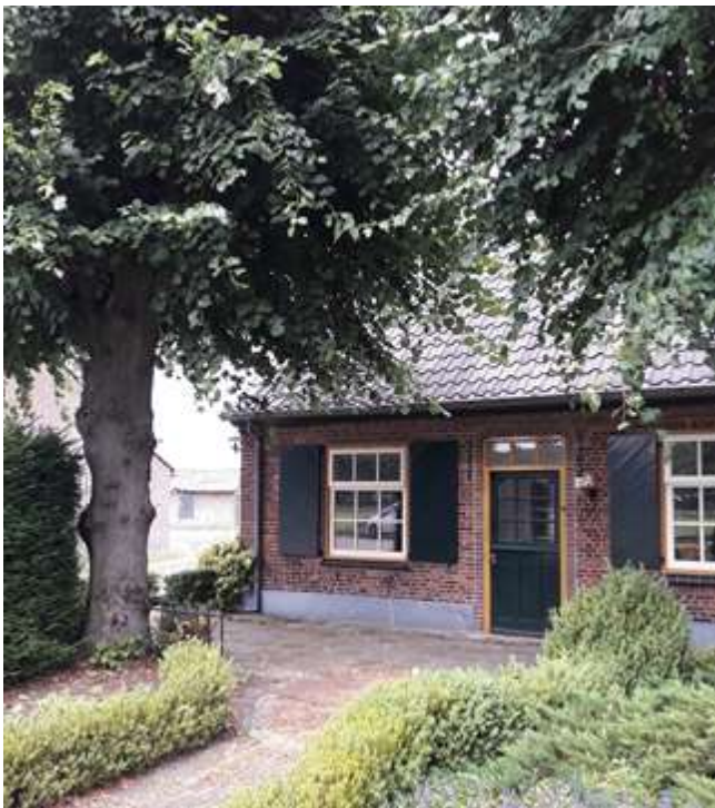
Bouwhistorische Waardestelling Bussereind 2a-3
