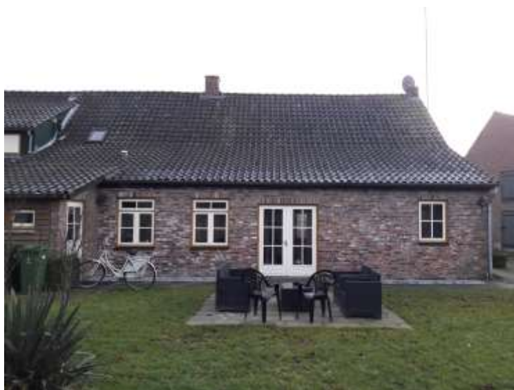
Afb. 20; noordgevel, westelijk deel (stramienen 1-4 van r.n.l.).
