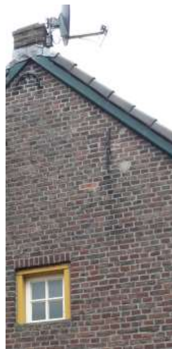
Afb. 15; westgevel, zoldervenster; makelaar.
