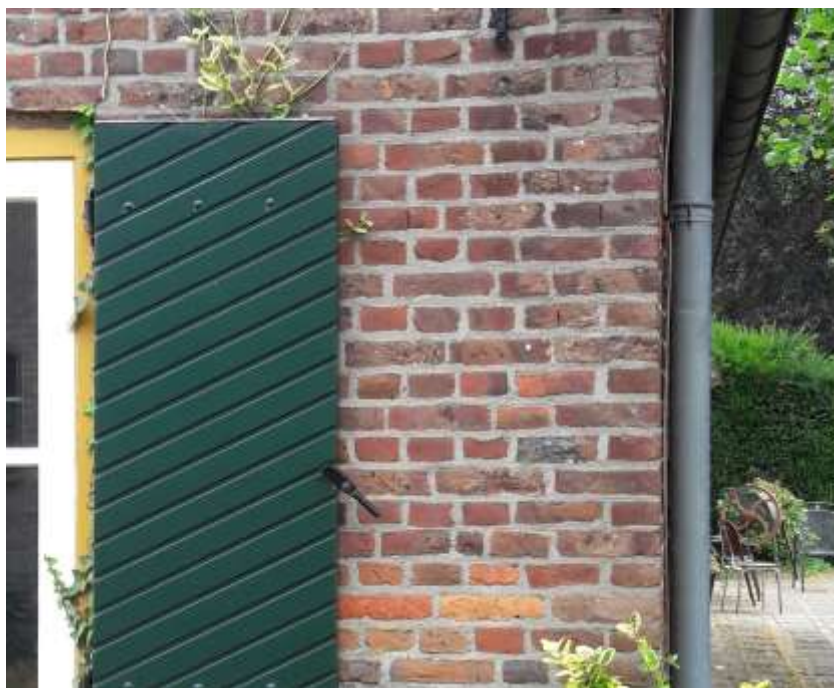
Afb. 14; westgevel, hoek met zuidgevel (voorgevel).
