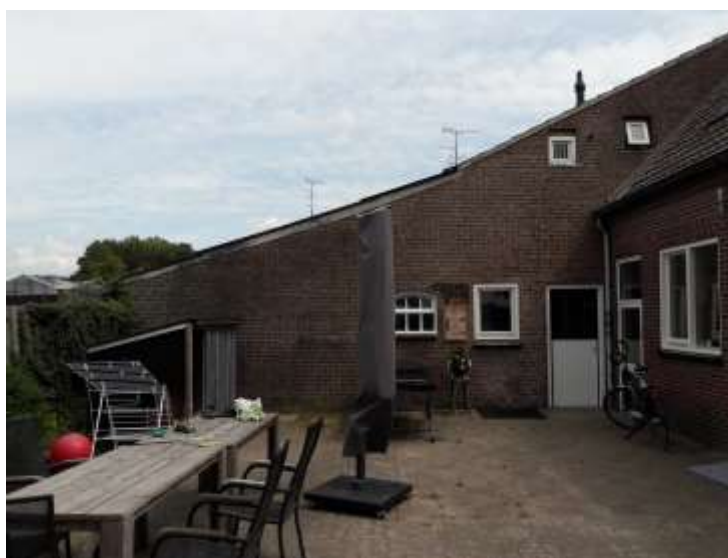
Afb. 18; brandmuur westzijde, deels ± 1930 en noordgevel woongedeelte.
