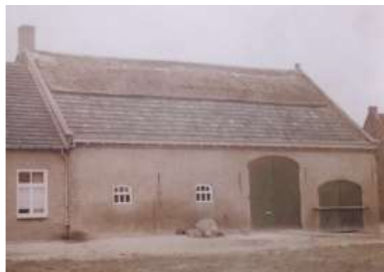
Afb. 12; de schuur na 1950 met aangebouwde woning.
