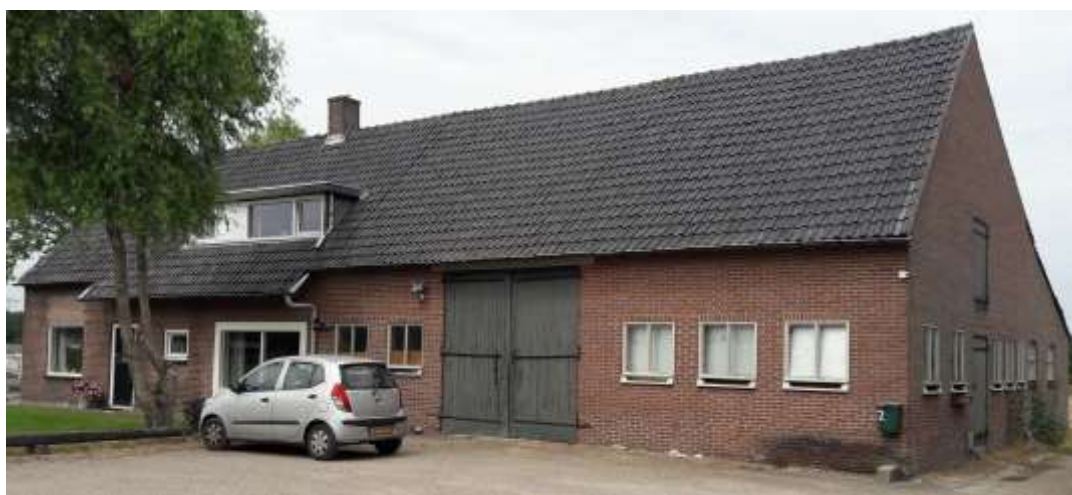
Afb. 14,15; zuidgevel met ingetekend de huidige toestand. Afb. 16; zuid- en oostgevel.
