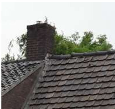
Afb. 25; achterzijde bij brandmuur.
