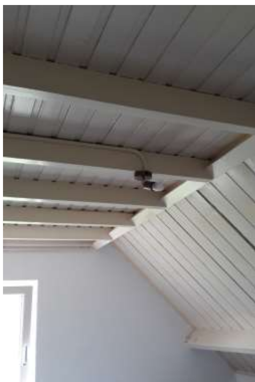
Afb. 33; ruimte II-v met dakbeschot en plafond.
