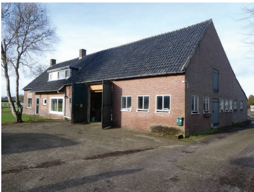
Voorgevel Bussereind 2, oostelijk deel, stal en schuur.
