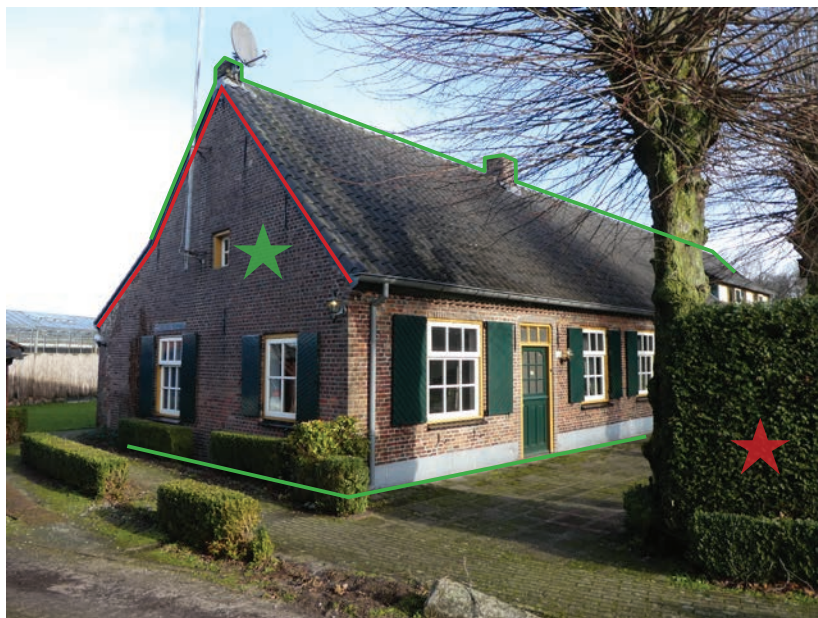
Voorgevel Bussereind 3, positieve en negatieve factoren.
