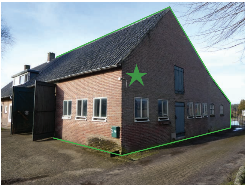
Voorgevel Bussereind 2, positieve en negatieve factoren.
