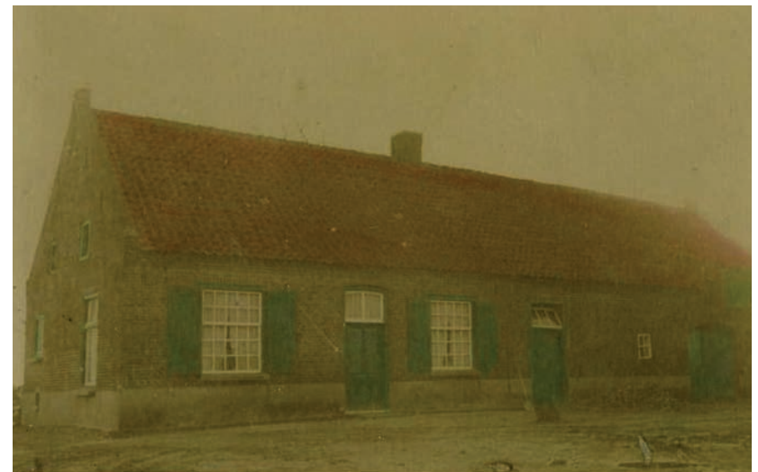
De boerderij aan het Sengelsbroek te Asten-Heusden heeft doorstekende topgevels en een sober kleurgebruik in groen en wit.
