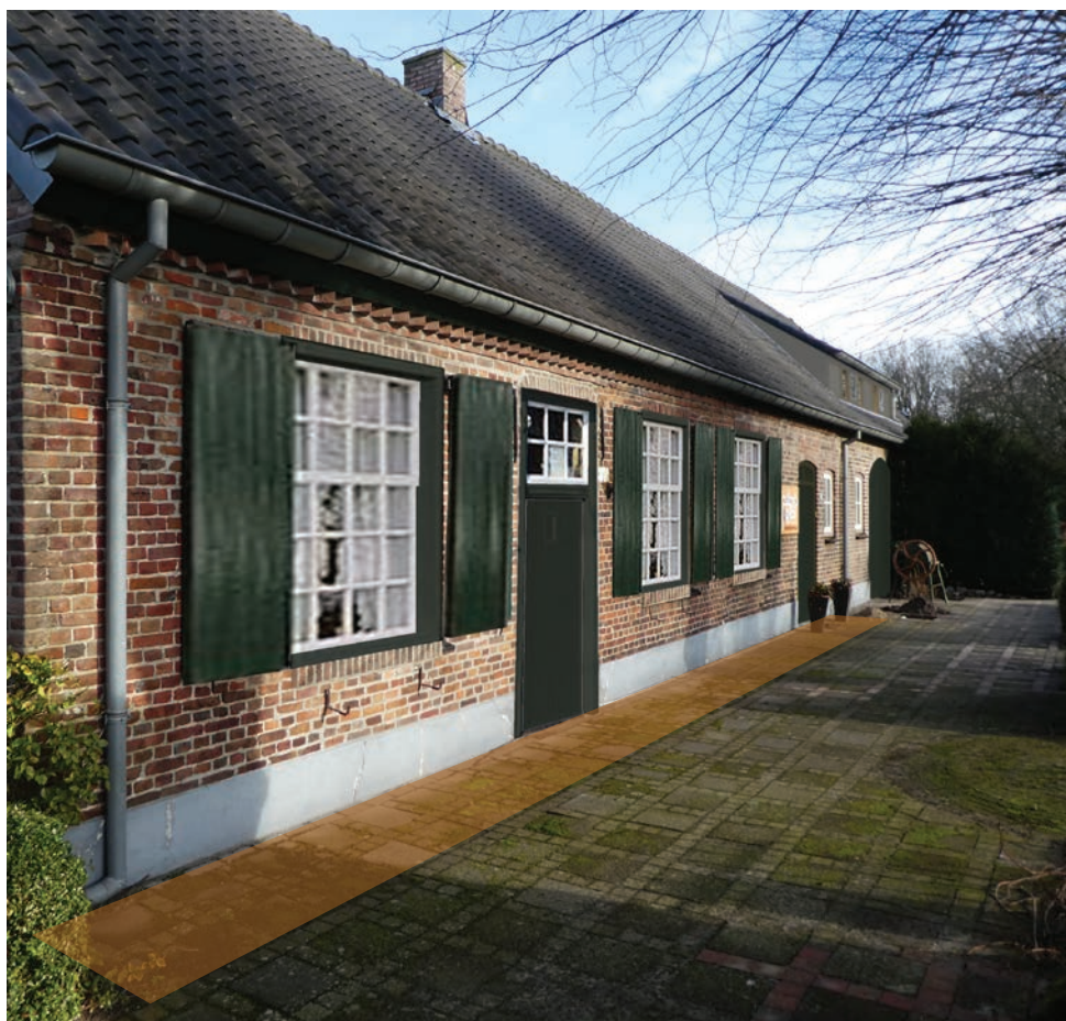
Impressie van het gevelbeeld van het oude woonhuis van Bussereind 3 na gevel-reconstructie en plaatsing van nieuwe kozijnen en kleur-reconstructie. De dakkapel is hier in een n.t.b. schaduw tint weergegeven.
