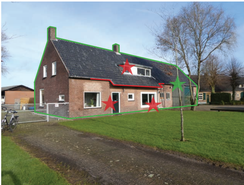
Voorgevel Bussereind 2, positieve en negatieve factoren.
