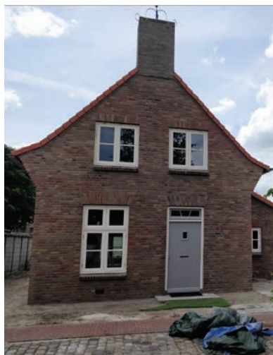
Voorgevel Bussereind 32, voor en na (rechts). De gevels zijn ontstoord en de vensters en deurpartij zijn gereconstrueerd. John van Lierop.
