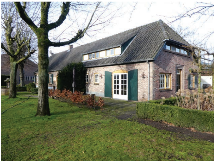
Voorgevel Bussereind 3, oostelijk deel, voormalige stal en schuur.
