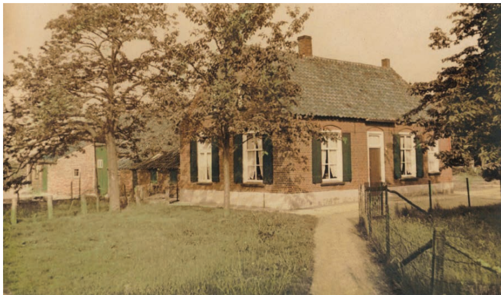
Ook een kleine boerderij in St. Anthonis heeft (had) een jaren '50 kleurbeeld met eenduidig wit kozijn- en raamwerk, een blanke deur als accent en helder-groene staldeuren en in dit geval luiken.
