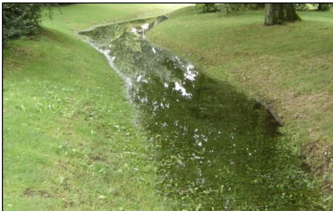
Figuur 16: Voorbeelden infiltratievoorzieningen op maaiveld niveau
