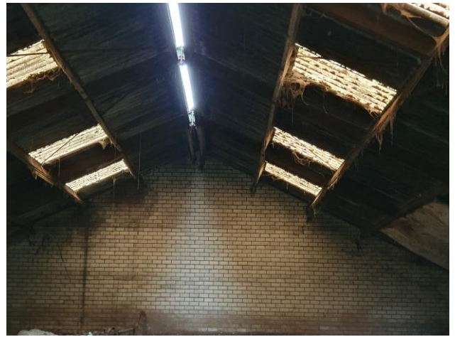
Te slopen rundveestal en een indruk van de golfplaten dakbedekking.
