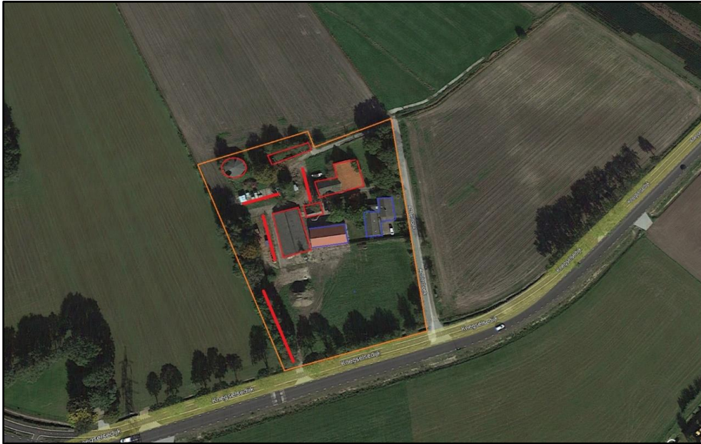
Figuur 2. Te saneren bebouwing en verharding Achterhoek 2 te Duizel (oranje), te slopen bebouwing en verharding (rood) en te behouden bebouwing (blauw). Bron: Google Earth.
