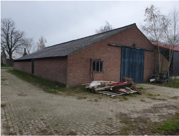
Te slopen rundveestal en een indruk van de golfplaten dakbedekking.
