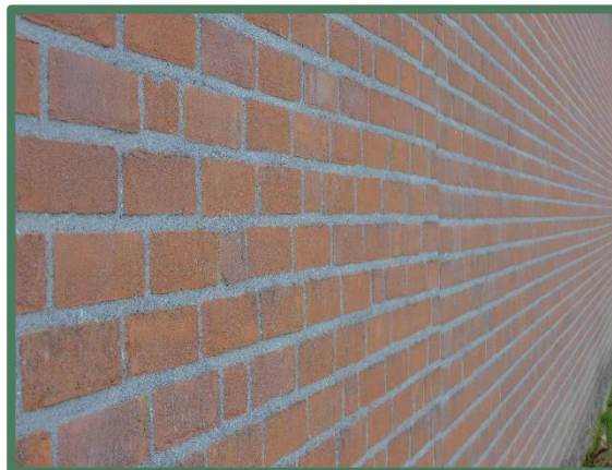
Gesloten muur achterzijde manege
