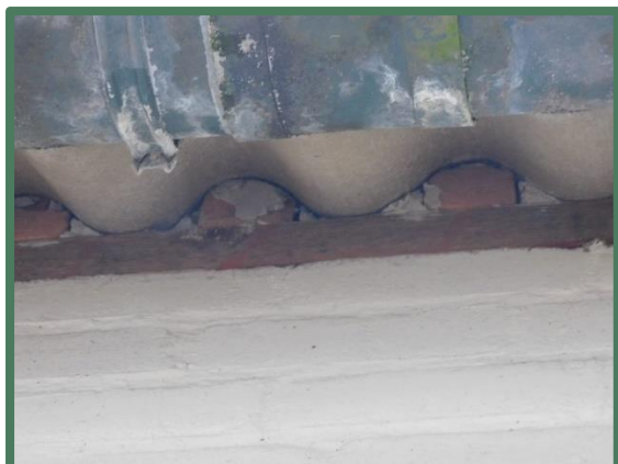
Muurplaat en gesloten opening tussen golfplaat en wand
