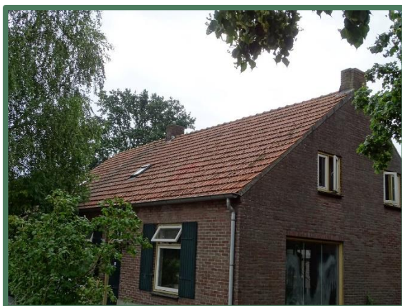
Woonhuis met gemetselde kopgevel
