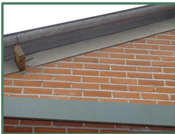
Gesloten dak loods
